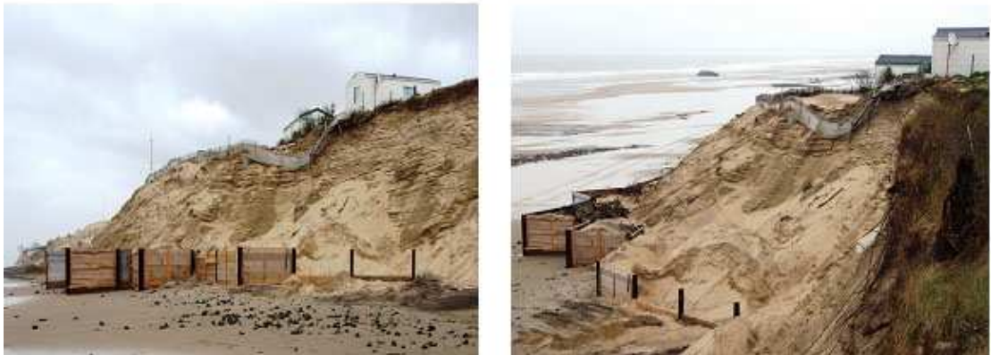
Illustration 24 : Photos de l'effondrement d'une falaise dunaire au niveau du camping des Sables (Soulac, avril 2008)
