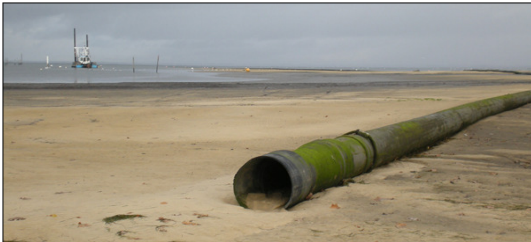
Document 17 : La DAS du SIBA pendant le dragage du chenal d'accès au port de la Hume. Cliché : Manciet Bruno.
