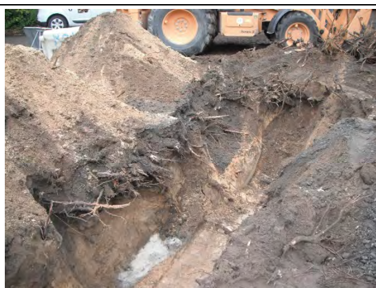
Vues de la tranchée
