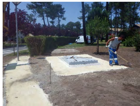
Finalisation de la dalle du nouveau poste de pompage
