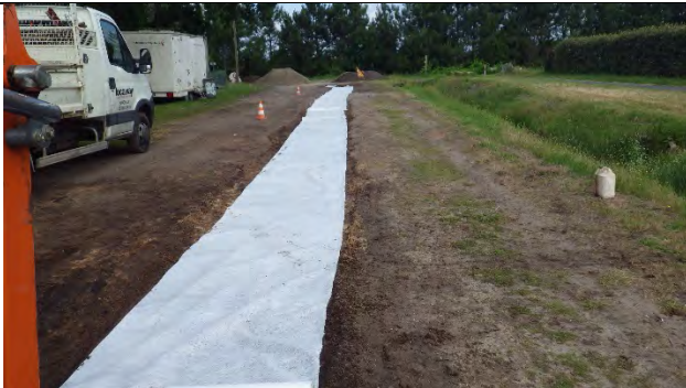
Vue de la tranchée avant fermeture
