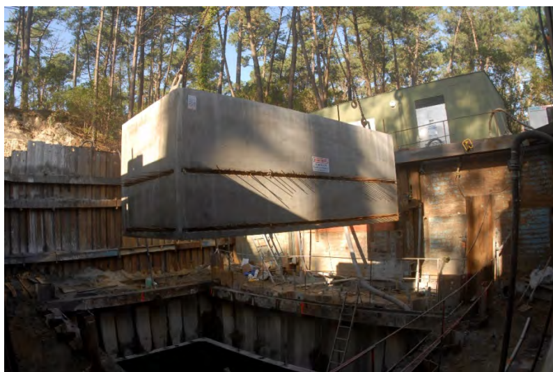
Mise en place d'un élément préfabriqué
