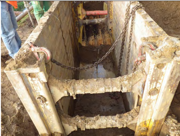
Vue du Blindage de la fouille
