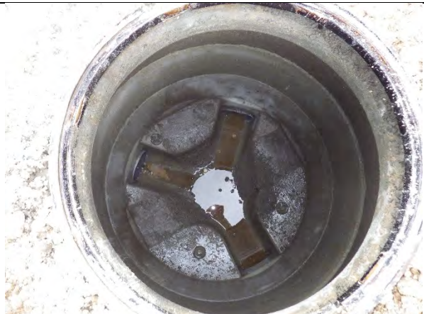
Vue intérieure d'un regard de visite
