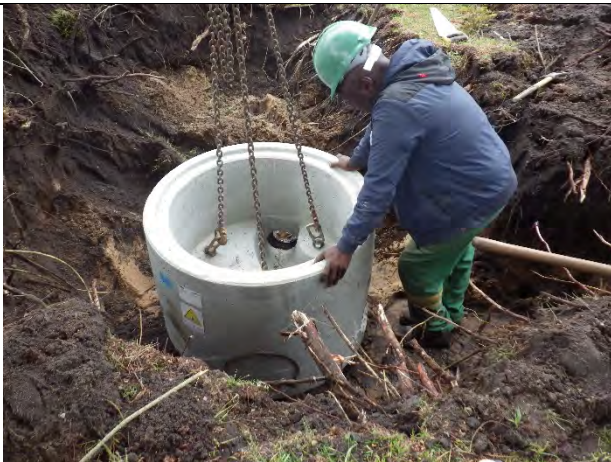
Pose d'un regard de visite
