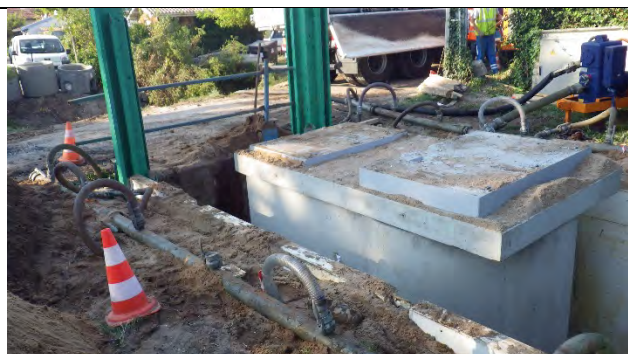
Pose de la bache de pompage
