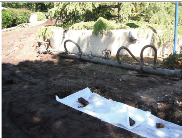
Vue de la tranchée et du rabattement de nappe
