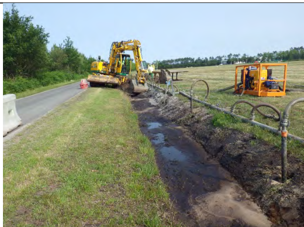
Vue de la tranchée avec le rabattement de nappe
