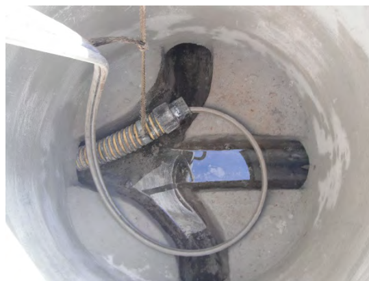
Curage du réseau d'assainissement
