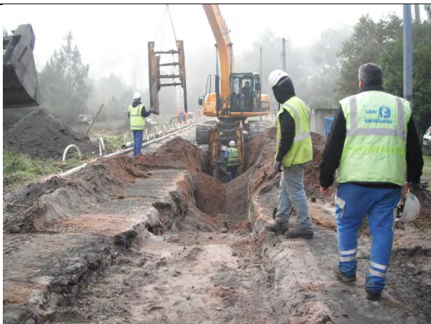
Réalisation de la tranchée et mise en place du blindage
