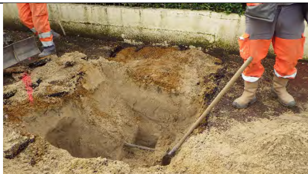
Fosse pour l'installation d'une nouvelle boîte de branchement
