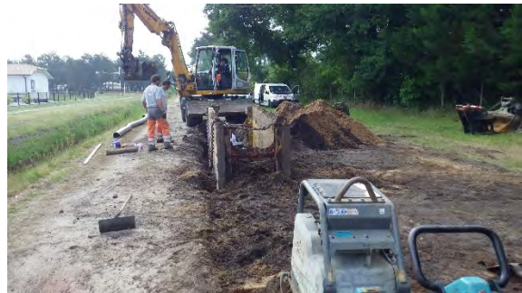
Pose de la canalisation d'assainissement
