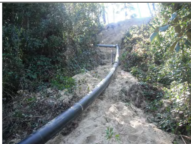
Vue de la nouvelle canalisation en PEHD
