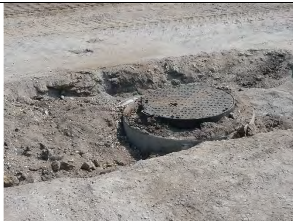
Regard de visite une fois posé
