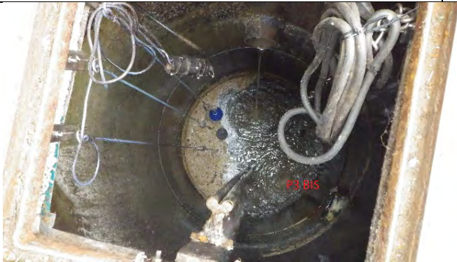
Vue de la bâche du poste P3 bis avant travaux
