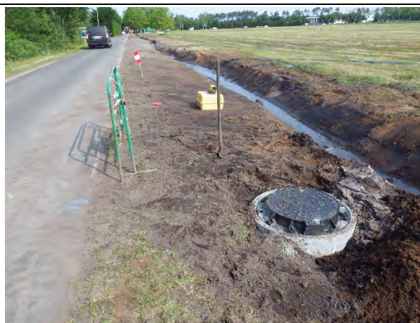
Vue de la tranchée et d'un regard de visite
