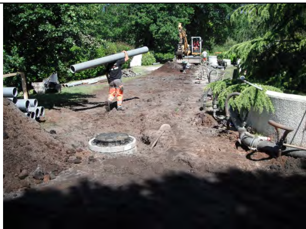
Vue général du chantier
