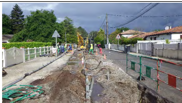
Vue de la Tranchée avec rabattement de nappe
