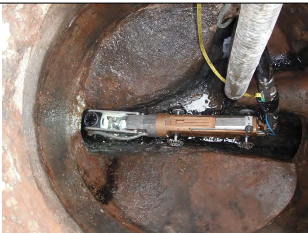
Vue du robot utilisé pour l'inspection caméra
