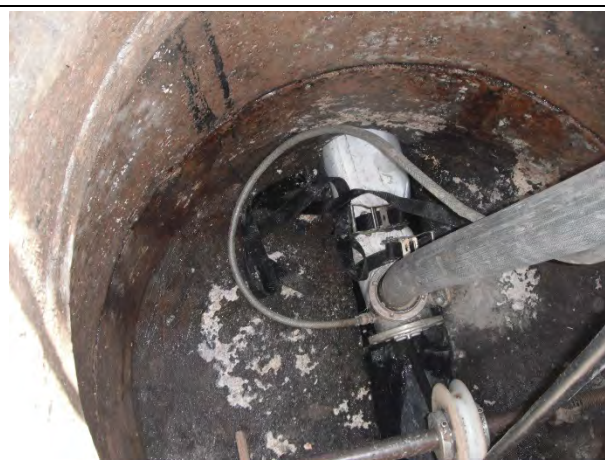
Injection du chemisage dans la canalisation
