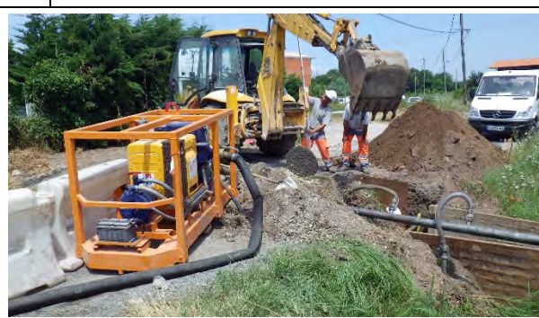
Pose du réseau d'assainissement
