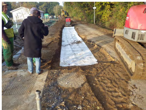
Emplacement de la canalisation gravitaire avant l'arrivée au poste de pompage
