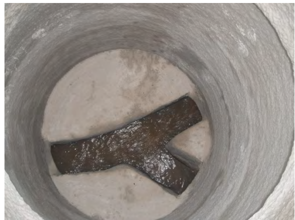
Vue d'un regard de visite refait à neuf
