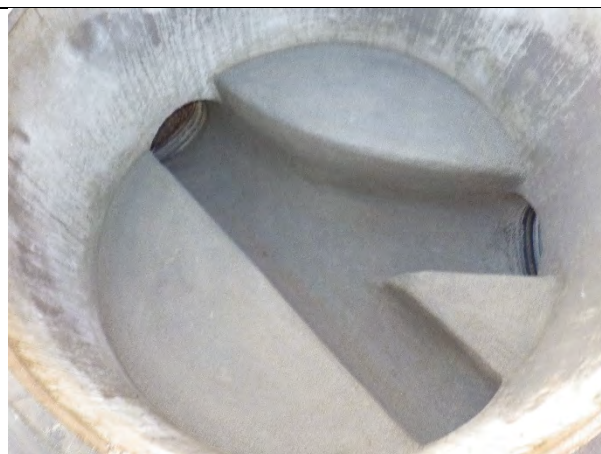
Intérieure d'un regard de visite neuf
