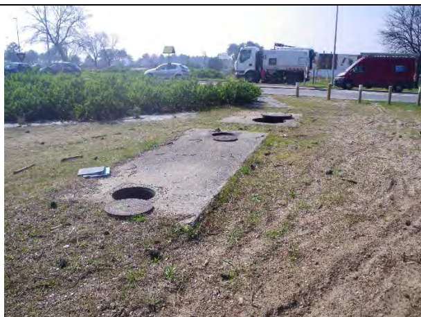
Vue des ouvrages au niveau du giratoire avant travaux
