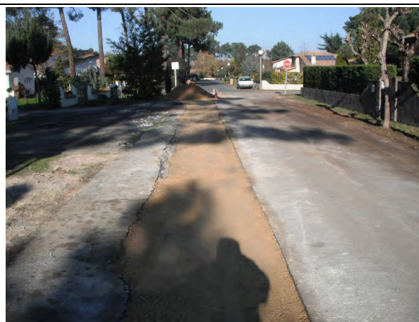
Vue de la tranchée une fois rebouchée
