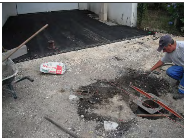
Changement d'une boîte de branchement
