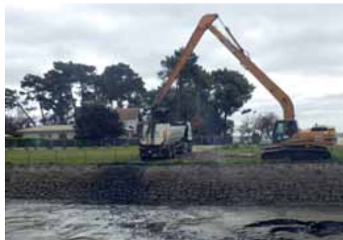
Dragage avec la pelle à long bras
