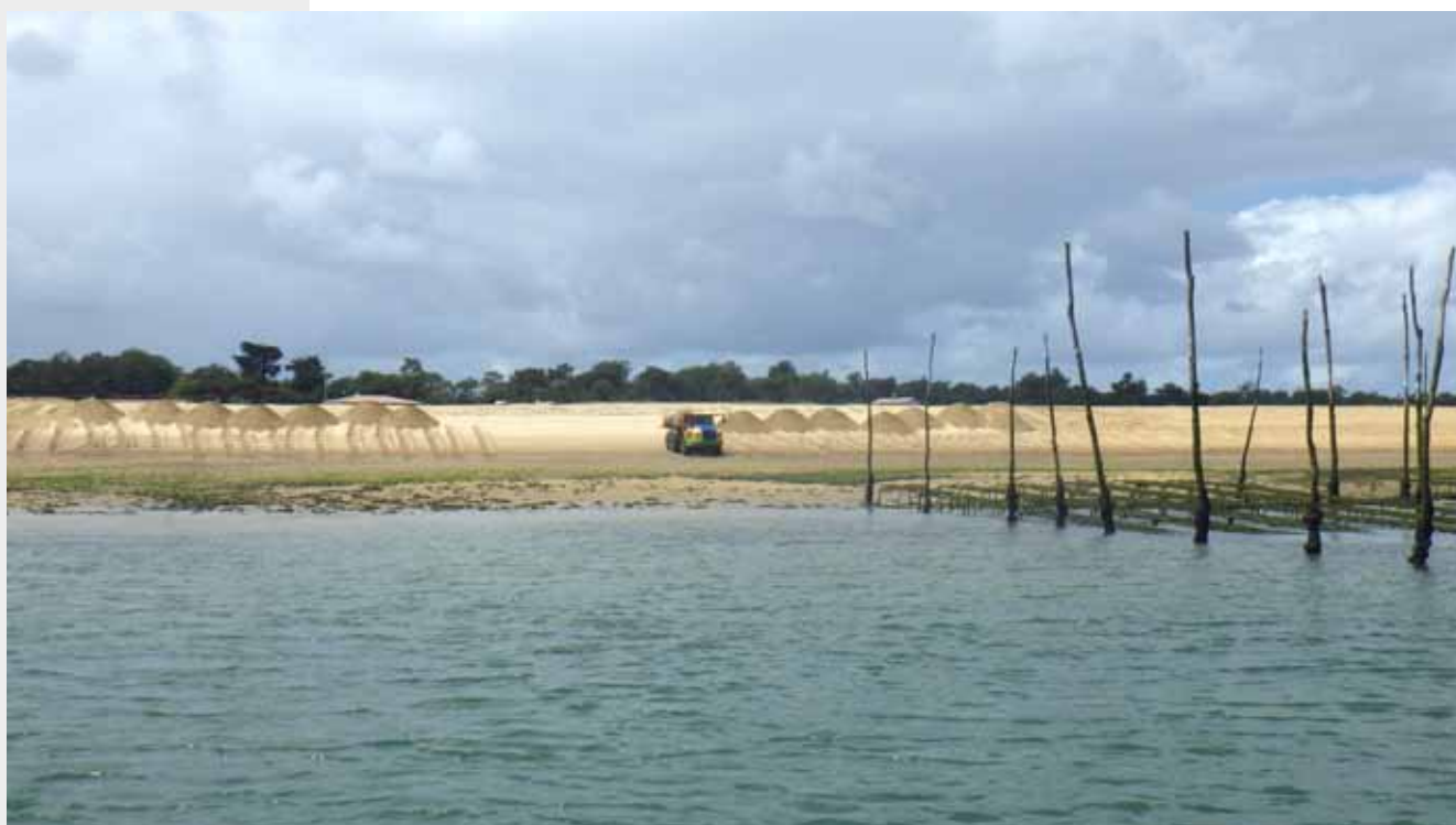
Travaux de rechargement de la flèche externe du Mimbeau
