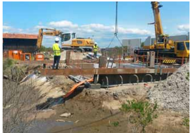
Coulage du béton entre prémurs
