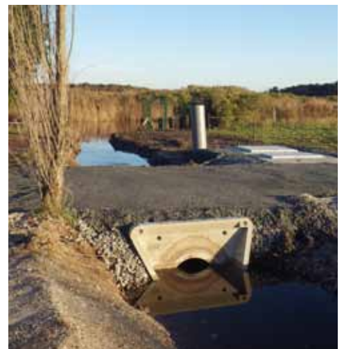
Poste en place et aménagements terminés
