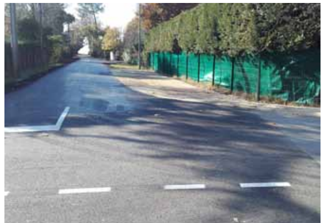
Réfection des enrobés de la voirie
