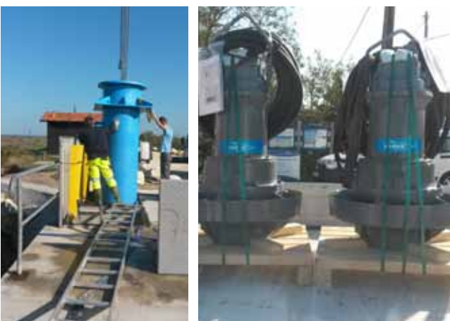
Mise en place des tubes et des pompes
