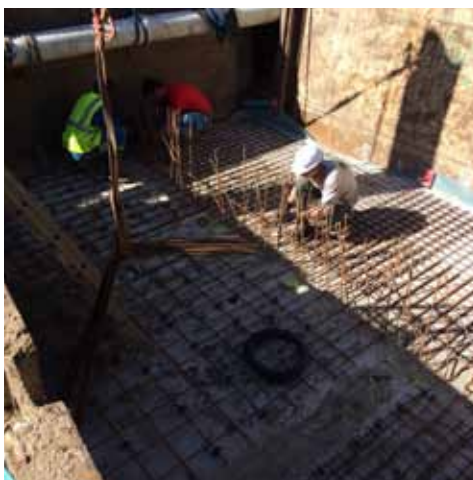
Coulage des fondations
