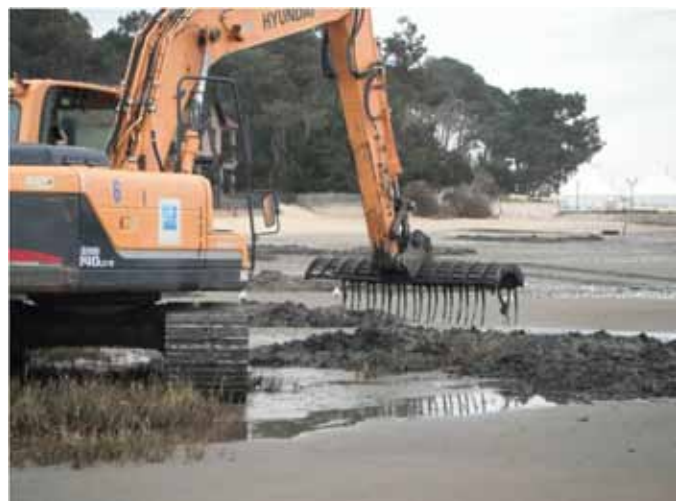
Chantier d'arrachage des spartines anglaise à Claouey
