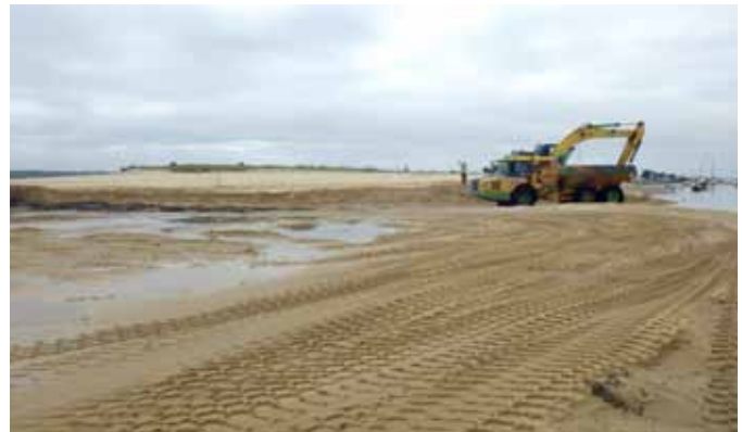
Travaux au Mimbeau
