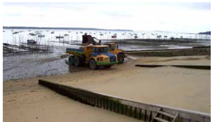
Travaux à l'Herbe
