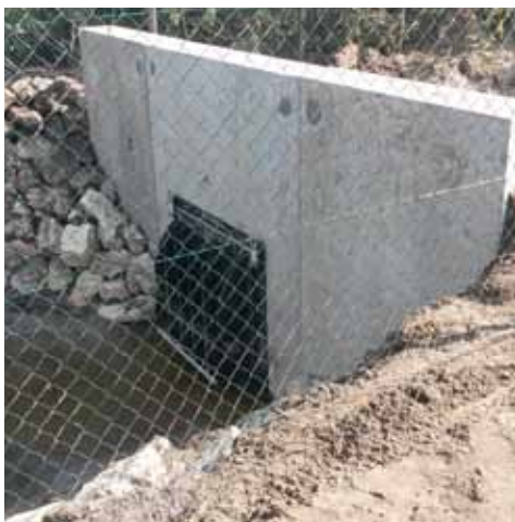
L'ouvrage terminé et son clapet
