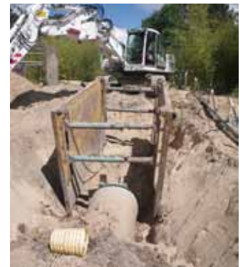
Remblais de tranchée avec sédiments de dragage
