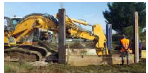
Pose du refoulement et terrassements pour construction du poste de pompage.
