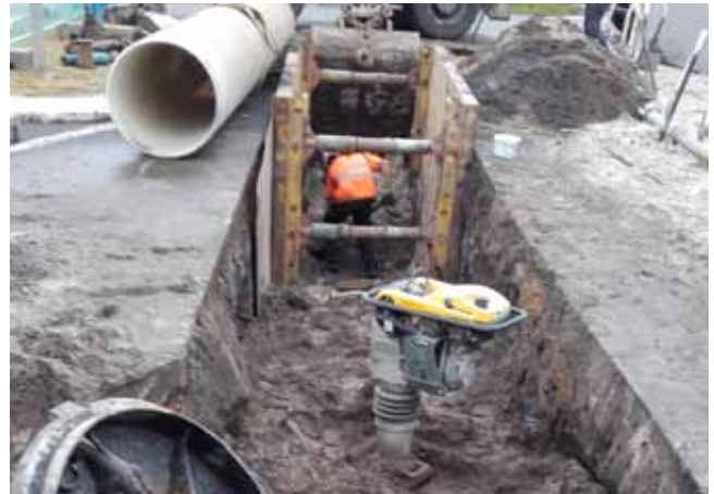
Pose de la canalisation en PRV de 700 mm
