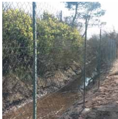
Rétablissement du cours d'eau et restauration des berges
