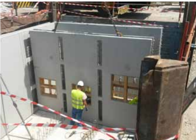
Mise en place des prémurs du poste de pompage
