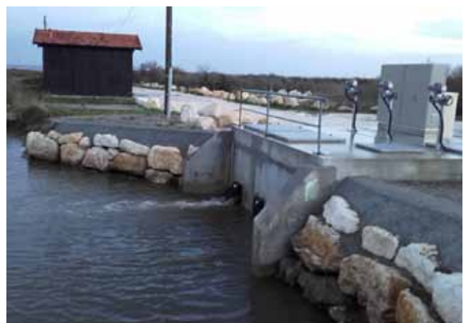
Poste et réfection des quais terminés
