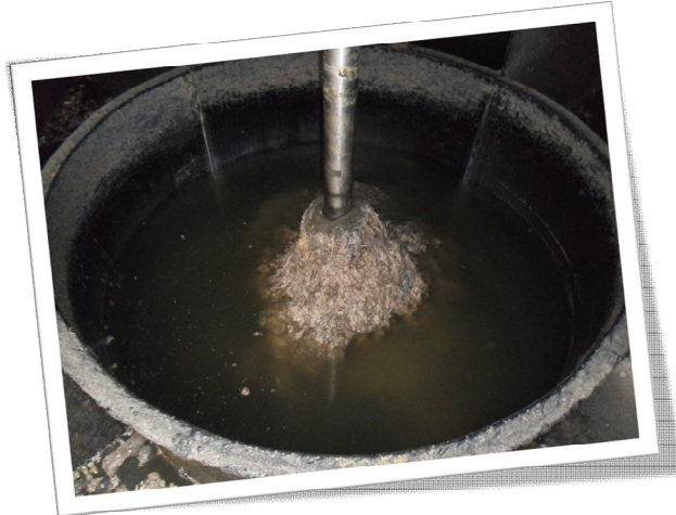
Filasses autour de l'axe de l'agitateur à pales sabres du flocculateur agité
