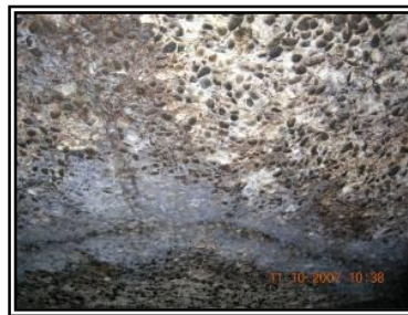
Fissures et dégradation apparentes des bétons
