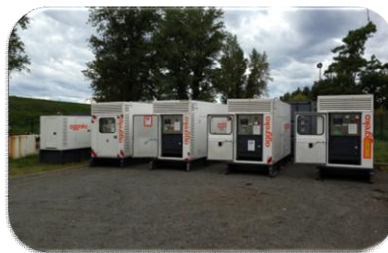
Installation des groupes électrogènes
