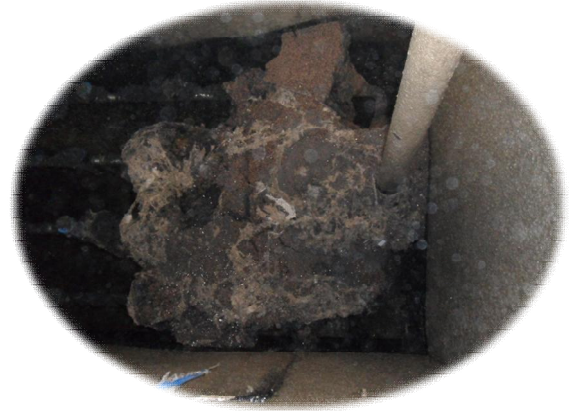
Filasses posées sur les vibrants des ouvrages de dessablage/dégraissage
