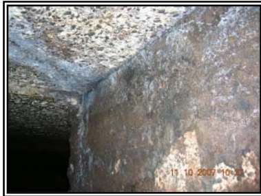
Fissures et dégradation apparentes des bétons
