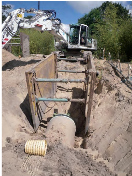
Remblais de tranchée avec sédiments de dragage
