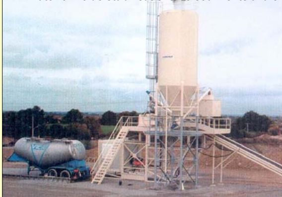
Plate-forme de stabilisation des sédiments à la chaux
