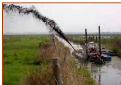
Figure 13 : Vue des lagunes avant remplissage / utilisation du canon à sédiments
