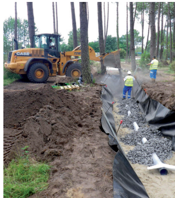
Mise en place des canalisations
