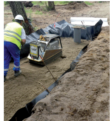
Compaction successive des couches jusqu'à comblement de la tranchée puis couverture en terre végétale
