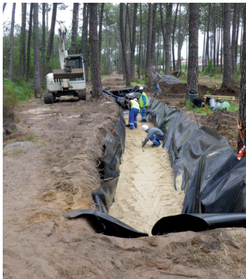
Remplissage de la couche drainante (sable)
