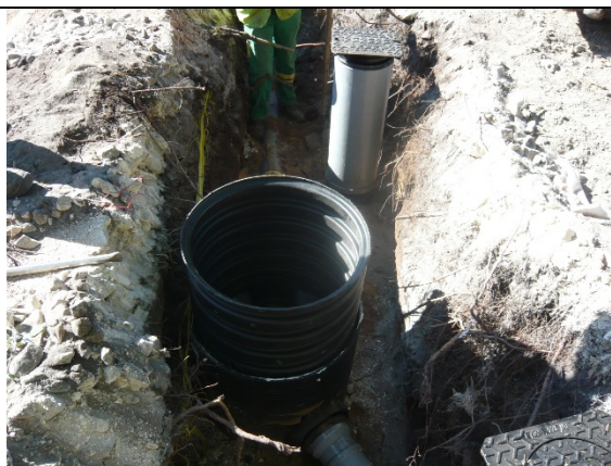
Pose d'un regard en PEHD et d'une boîte de branchement
