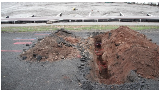
Réalisation de sondage pour afin de déterminer l'emplacement exacte de la future canalisation
