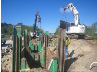
Détail des blindages
