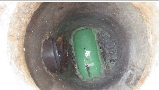
Vue de la gaine après durcissement et avant réouverture
