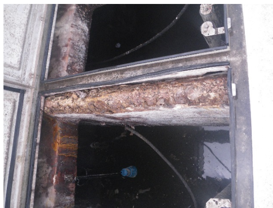
Détail des poutres
