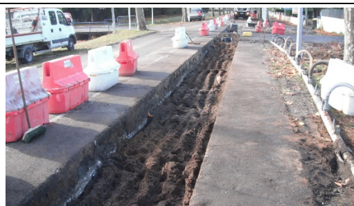
Vue de l'emprise de la tranchée
