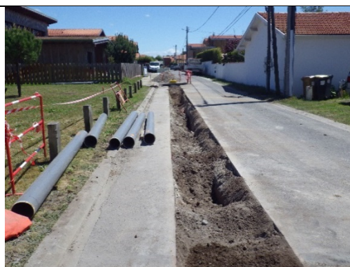
Vue de la tranchée avant pose du nouveau réseau en PVC
