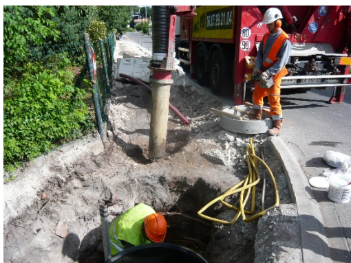
Réalisation de fouille à l'aspiratrice
