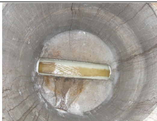
Vue de la cunette gainée après découpage
