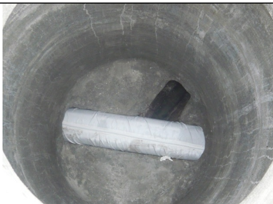
Vue de la gaine pendant l'opération de chemisage
