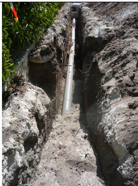
Vue de la nouvelle canalisation en PVC
