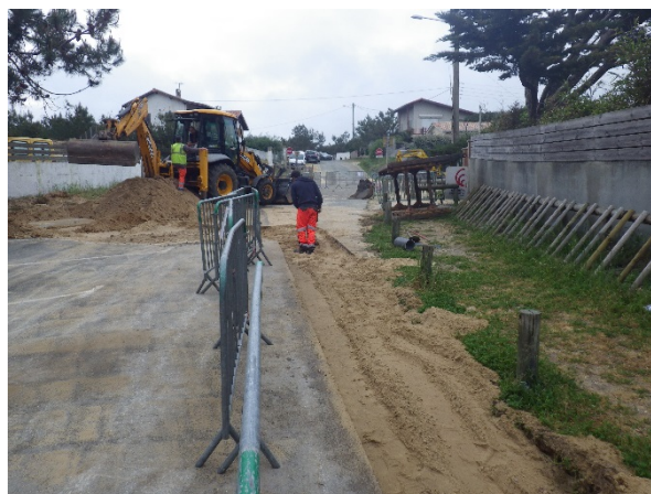
Vue de l’emprise de la tranchée de la nouvelle canalisation
