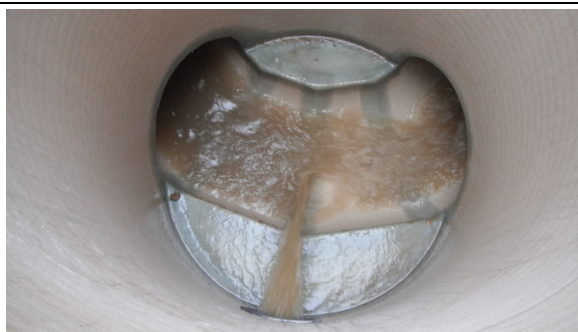
Vue de l'écoulement à l'intérieur d'un regard en PRV résistant aux attaques chimiques
