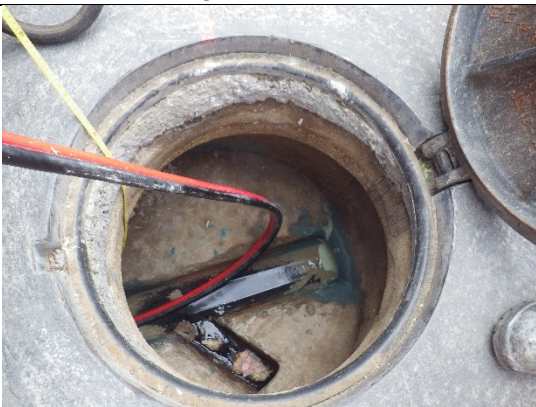
Vue d'un regard de visite pendant l'opération de l'inspection caméra
