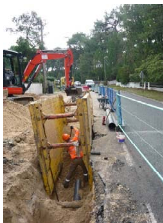
Vue de la tranchée avec blindages
