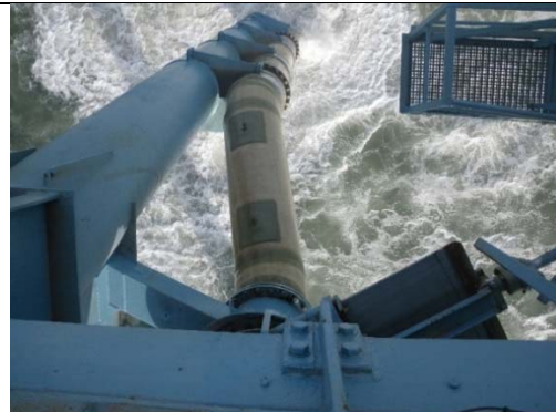
Vue de l'exutoire secondaire en fonctionnement
