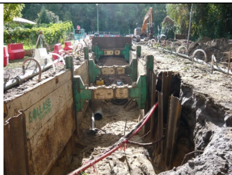
Détail de la tranchée commune
