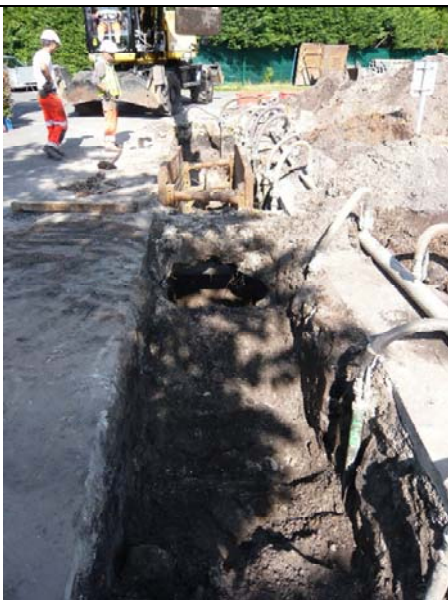
Vue de la tranchée avec blindage et rabattement de nappe
