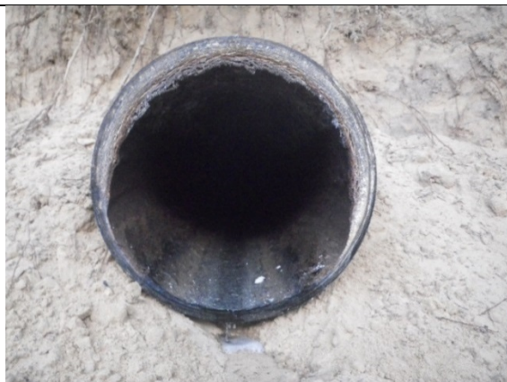
Détail de la canalisation existante
