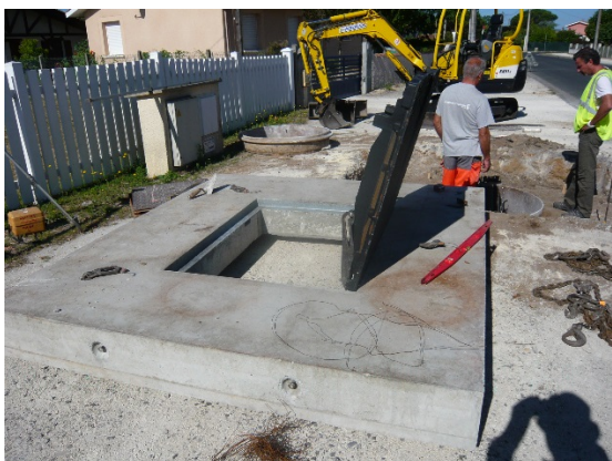
Vue de la nouvelle dalle
