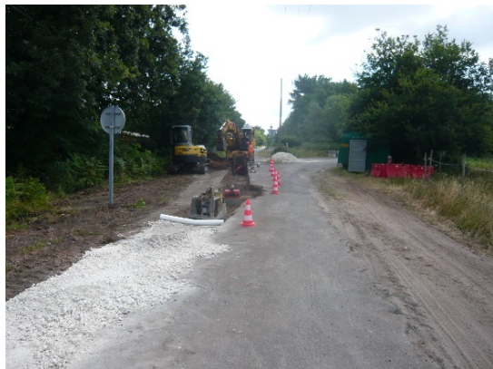
Vue d'ensemble du chantier
