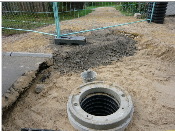
Mise en place d'un regard PEHD plus résistant aux attaques d'H 2 S
