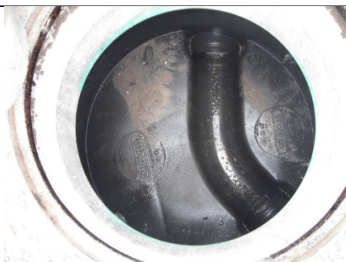
Vue d'un regard de visite en PEHD, résistant aux attaques chimiques
