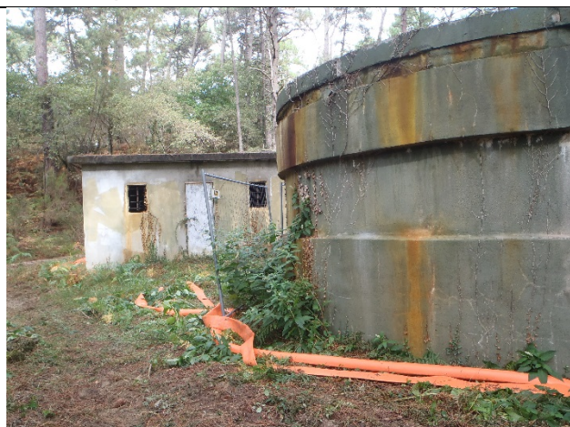
Chambre de mise en vitesse avant travaux
