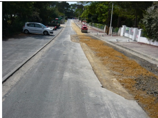
Emprise de la tranchée sur la partir de l'Allée des Mimosas donnant sur la rue des Goëlands
