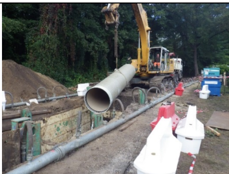
Pose des conduites en PRV
