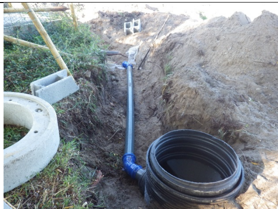
Vue de la nouvelle canalisation de refoulement et d'un regard PEHD
