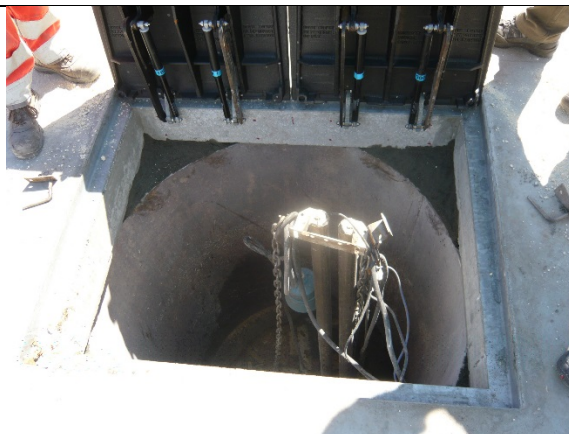
Vue de la trappe d'accès une fois la dalle posée
