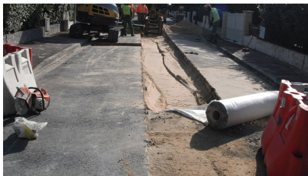
Vue de la tranchée de la nouvelle canalisation
