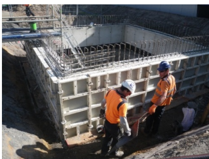
Poste de pompage Perrault – coulage de la trousse de havage
