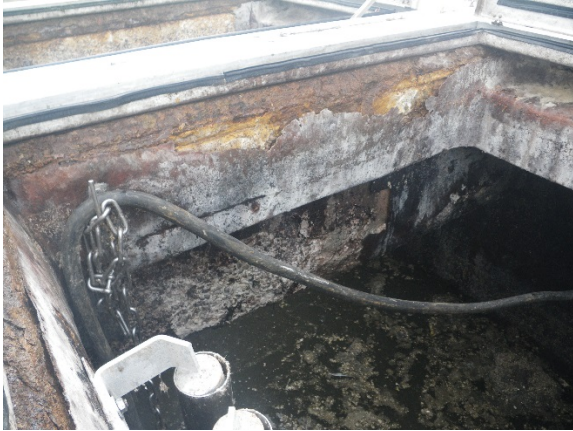
Détail de la dalle
