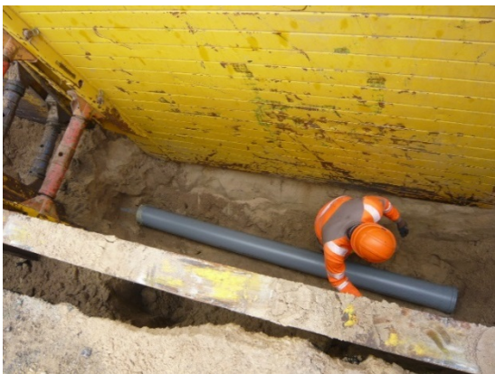
Pose d'une canalisation PVC Ø200 avec vue du blindage
