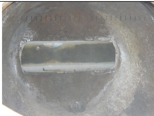
Vue d’une cunette chemisée
