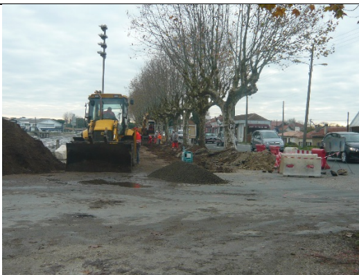
Vue d'ensemble du chantier
