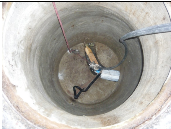
Vue d’un regard de visite rénové
