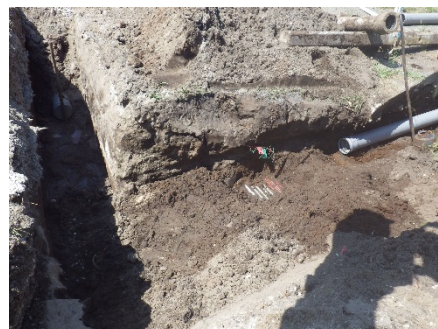
Vue de la tranchée et d'une canalisation de branchement
