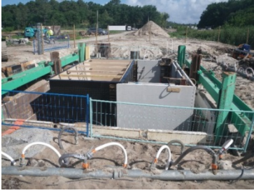
Ouvrage de surverse
