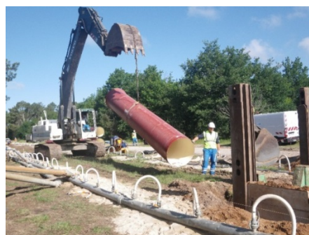
Collecteur – pose des conduites
