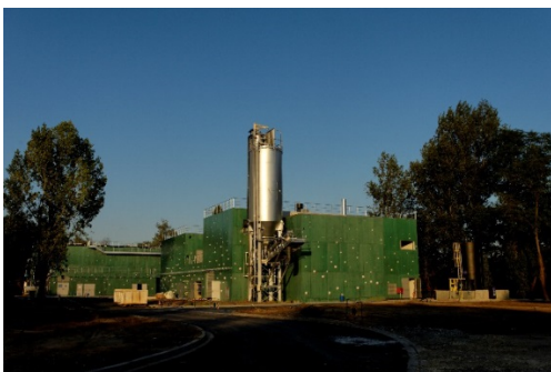
Silo supprimé de la STEP de Biganos
