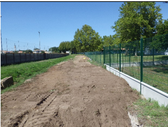
Vue de l'emplacement de la tranchée de la canalisation gravitaire
