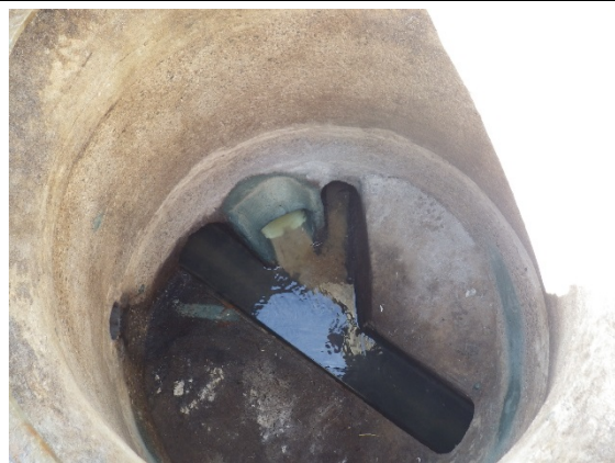
Vue de l'arrivée du réseau chemisé
