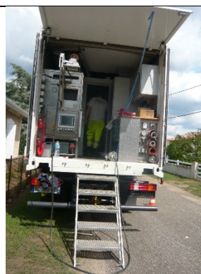
Vue du camion accueillant l'unité de contrôle télévisé des canalisations
