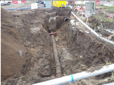
Vue de la canalisation à remplacer carrefour avenue de Candale – chemin de la Procession
