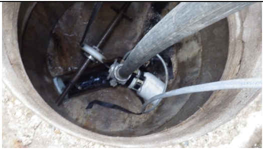
Injection de vapeur pour plaquer la gaine aux parois de la canalisation existante
