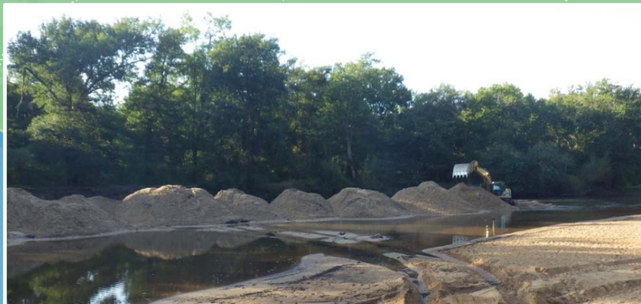
Préparation de la zone d'extraction, création d'un merlon dans la Leyre
