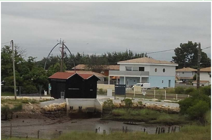
GUJAN-MESTRAS, Port de la Molle Création d'un poste de pompage
