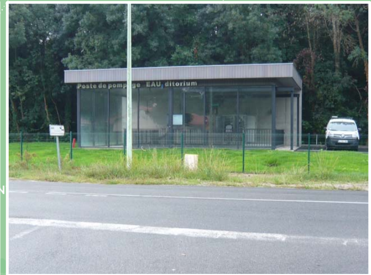
BIGANOS - Eau d'itorium Création d'un poste de pompage
