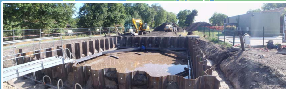
Taussat - poste de pompage – CHANTIER EN COURS
