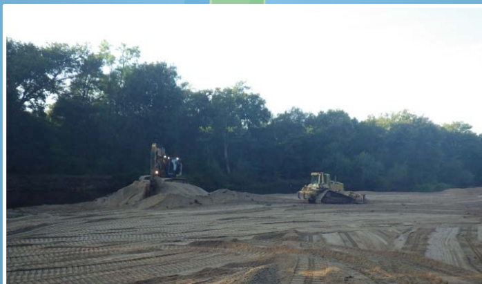
Nivelage du merlon pour permettre le passage des dumpers
