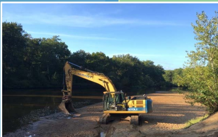
Mise en place de la pelle pour l'extraction du sable
