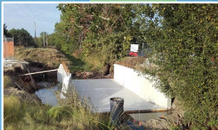
LE TEICH, Craste Baneyre Remplacement d'une traversée sur la craste Baneyre
