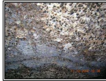
Fissures et dégradation apparentes des bétons
