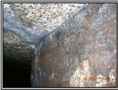
Fissures et dégradation apparentes des bétons
