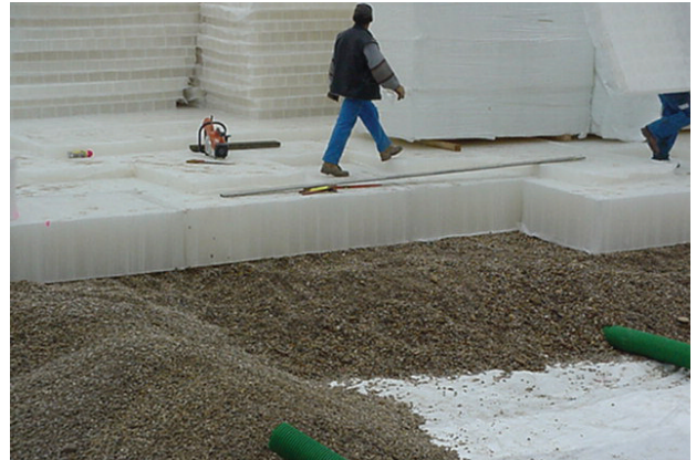
Commune de Lège-Cap Ferret : réduction des inondations.
