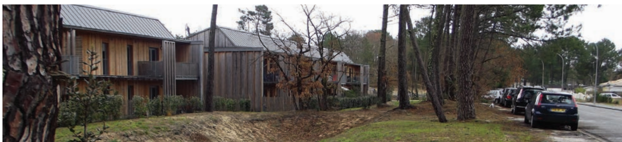
Noue en site « sable des Landes » avec présence de la nappe phréatique à faible profondeur.
