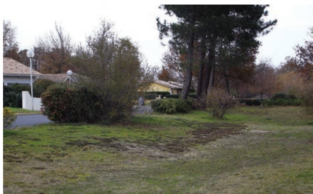
Noue en site « sable des Landes » avec présence de la nappe phréatique à faible profondeur.
