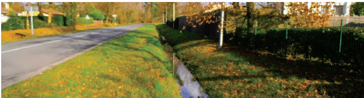
COMMUNE DE BIGANOS Fossé avec banquette - Maître d'ouvrage privé
