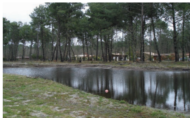
Noue en site « sable des Landes » avec présence de la nappe à faible profondeur, fonction : stockage, infiltration, régulation.
