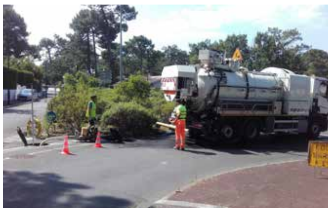
Nettoyage de bassins de rétention, Arcachon
