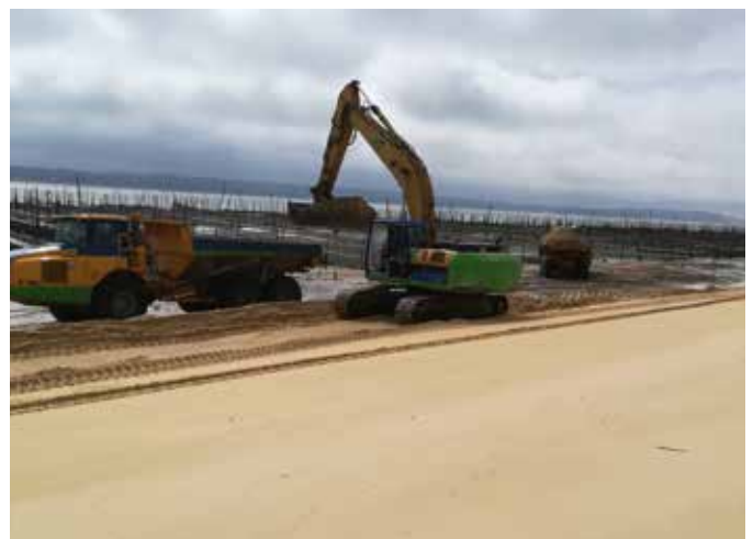
Pendant travaux, talus du Mimbeau
