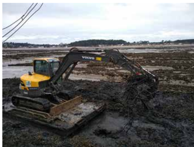
Pelle sur ponton flottant et non dameuse
