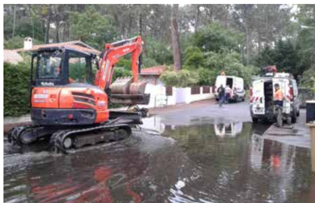
Travaux de création de réseau, Arcachon
