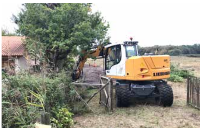
Curage de fossé en cours, Arès
