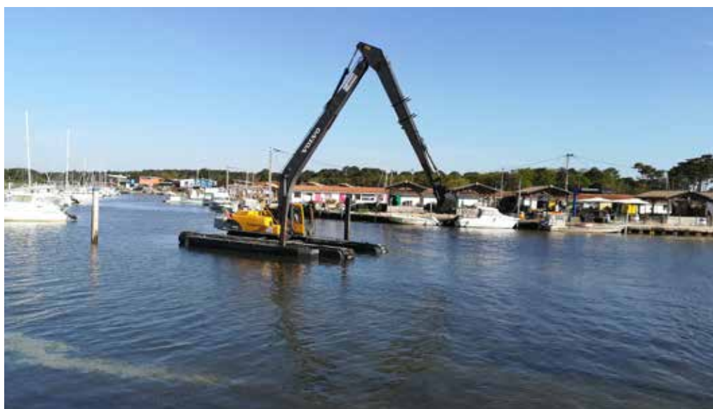
Pendant les travaux, Port ostréicole
