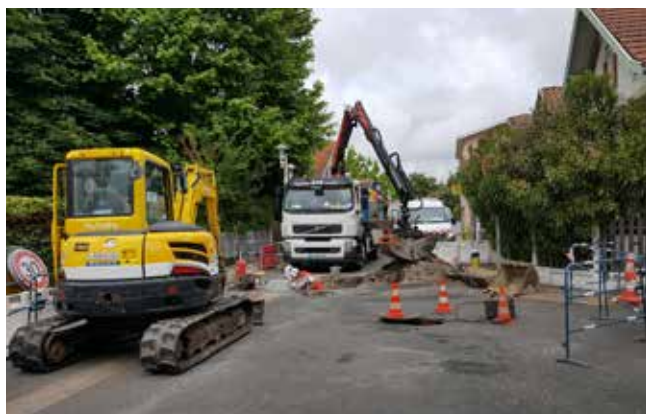
Travaux ponctuels de renouvellement de réseau, Lanton
