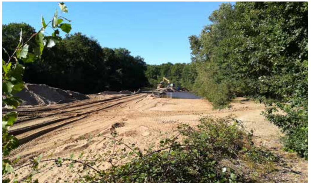
Chantier en cours
