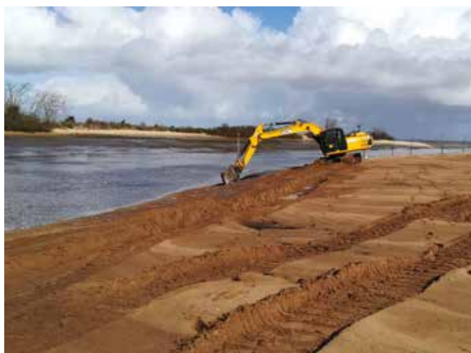
Pendant travaux, plage de la Hume
