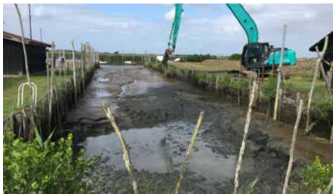
Pendant les travaux, Port des Tuiles
