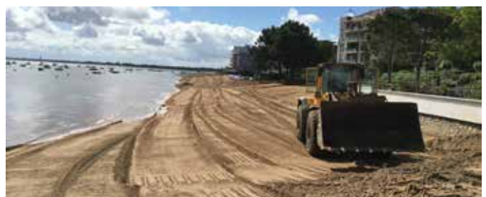
Pendant travaux, plage de L'Aiguillon
