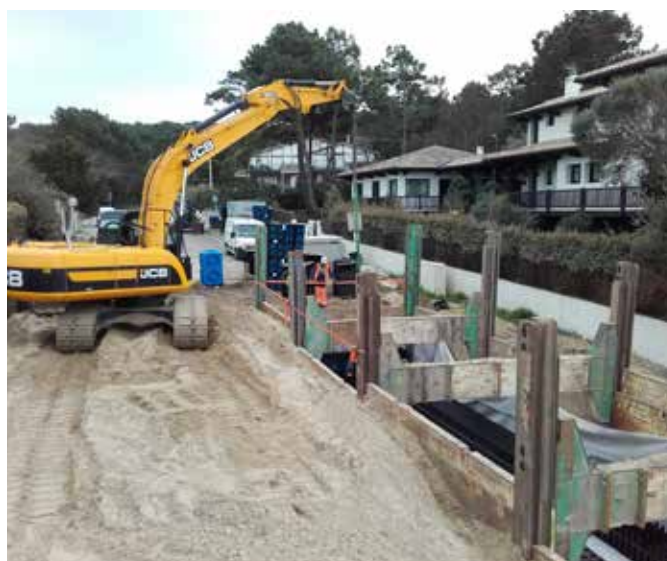
Avenue du Casino
