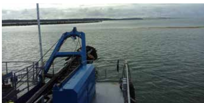
Banc de Bancot depuis la drague, pendant les travaux
