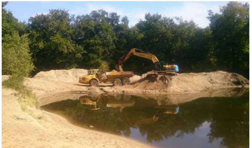
Chantier en cours
