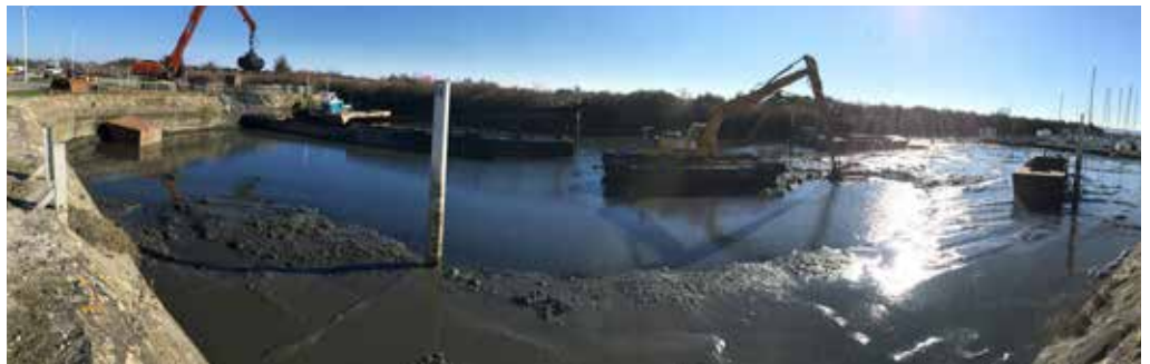
Pendant les travaux/darse sud
