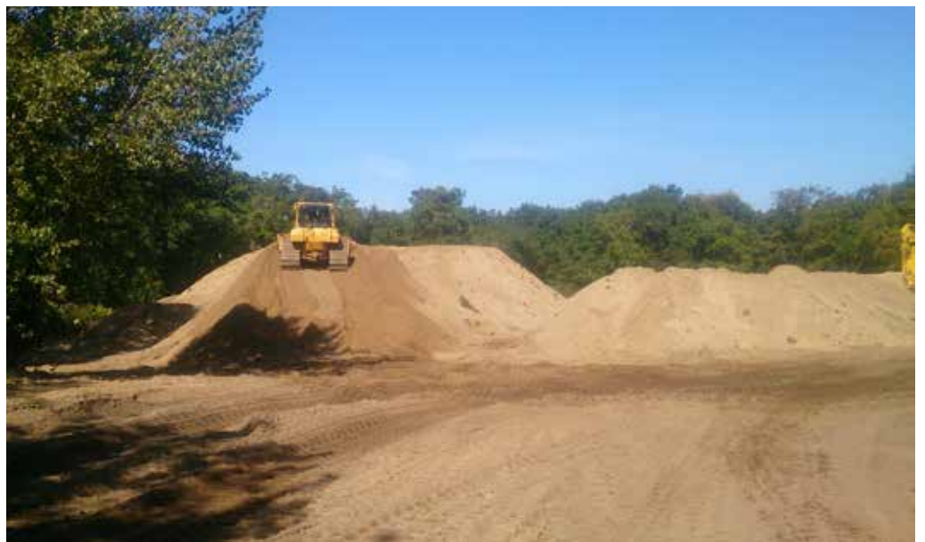
Plateforme de stockage
