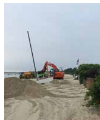
Pendant travaux-plage de Bélisaire
