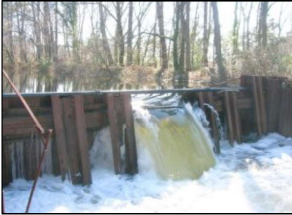
Fig. 8 à 11 : Barrages en palplanches établis par l'armée allemande lors de la seconde guerre mondiale à l'emplacement des anciennes écluses détruites (Source : internet).
