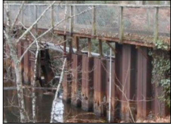
Fig. 8 à 11 : Barrages en palplanches établis par l'armée allemande lors de la seconde guerre mondiale à l'emplacement des anciennes écluses détruites (Source : internet).
