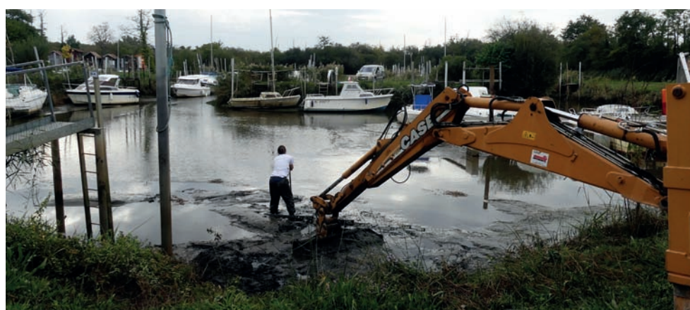
Intervention d'arrachage de Jussie au Port de Biganos © PNRLG
