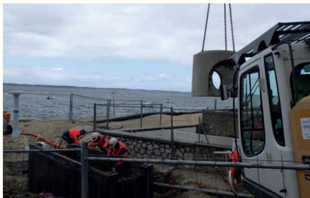
Terrassements pour la pose du collecteur de l'impasse Montaut, Arcachon
