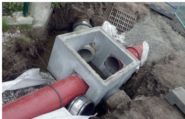
Pose d'un regard de visite destiné sur le réseau neuf, Andernos-les-Bains
