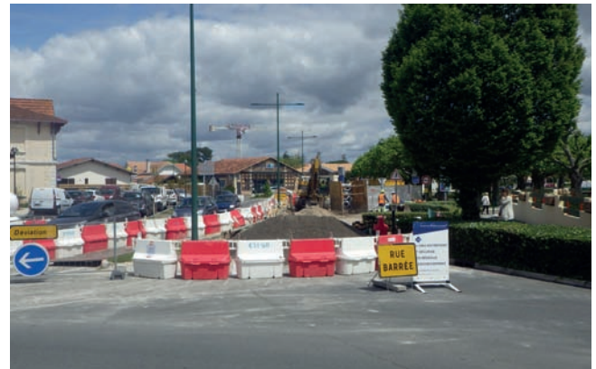
Balilage de la zone de chantier pour le maintien de la circulation, Gujan-Mestras
