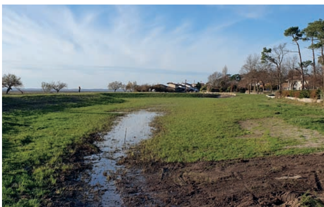
Travaux d'aménagements paysagers sur les noues, Lanton
