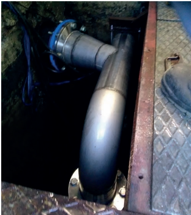
Réparation d'une conduite de refoulement, Poste de pompage de Desbief, Arcachon
