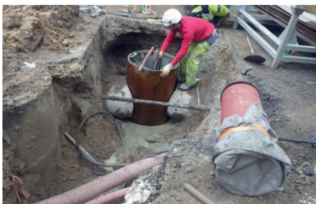
Création d'un regard de visite sur le réseau à existant, Arcachon
