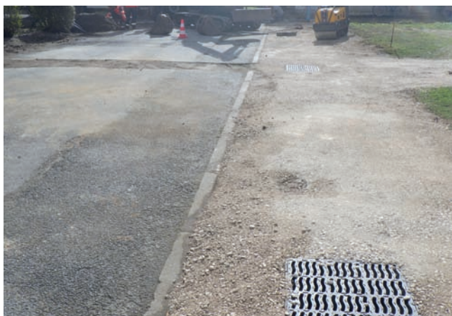
Vue de l'accotement aménagé en tranchée d'infiltration, Le Teich
