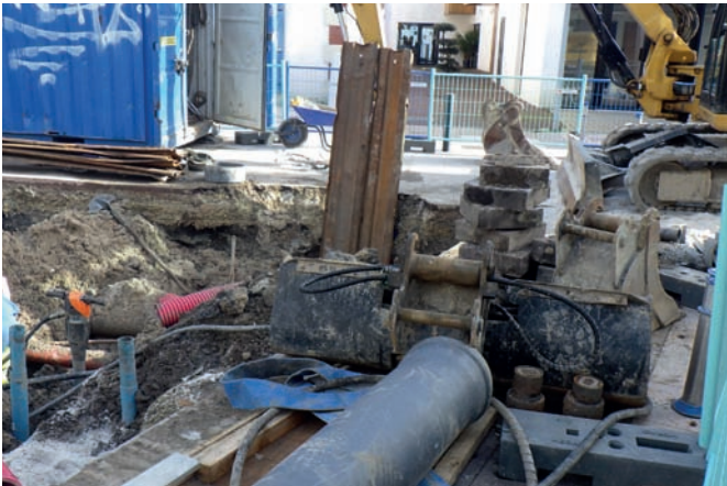
Pose de réseau en milieu urbain encombré par de nombreux concessionnaires
