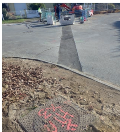
Pose d'une traversée d'eaux pluviales vers le réseau existant, Audenge
