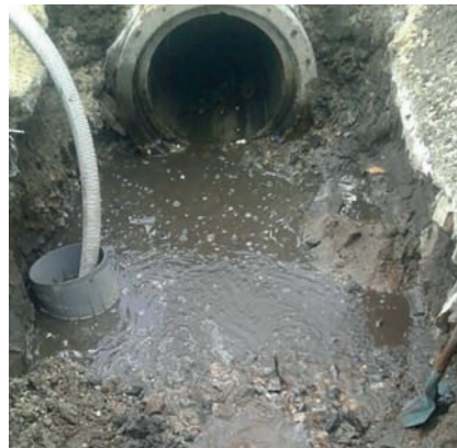
Vue de la réduction hydraulique existante après l'ouverture de la fouille, La Teste de Buch
