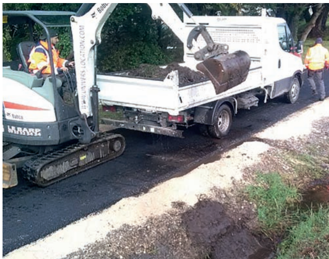
Curage de fossé en cours, La Teste de Buch
