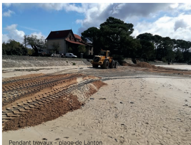
Pendant travaux - plage de Lanton
