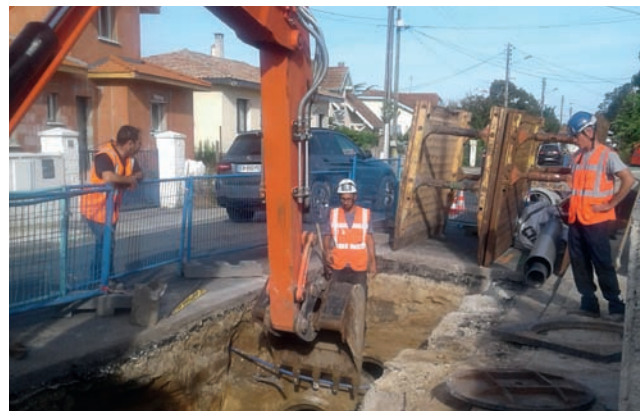
Terrassements pour renouvellement du regard et du réseau affaissé, Gujan-Mestras
