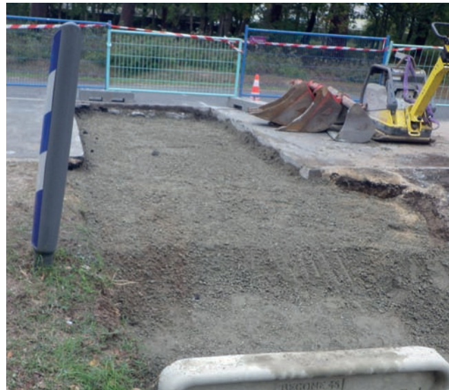
Repose d'une traversée de route, rue Suffren, Lège-Cap Ferret
