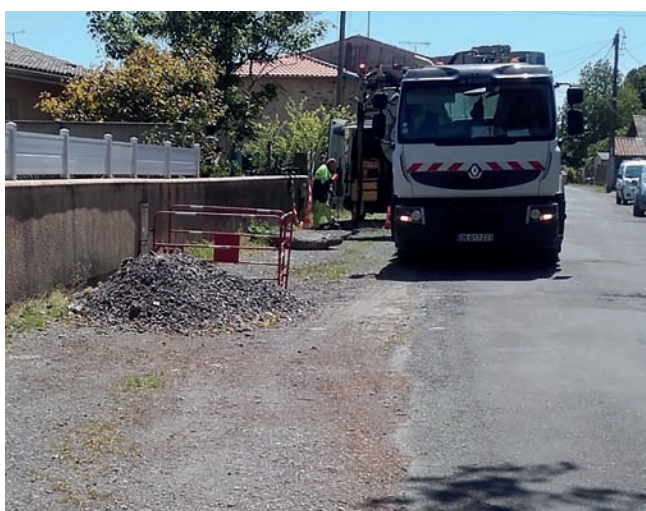
Hydrocurage-caméra sur la commune du Teich
