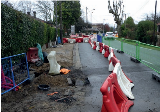
Balilage de la zone de chantier destiné à maintenir les accès piétons, Arès
