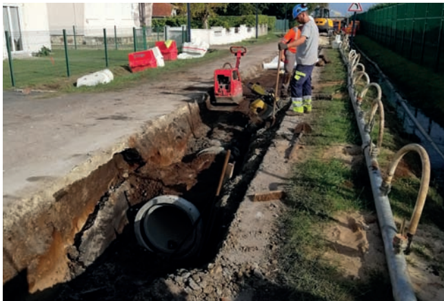
Pose du collecteur béton en DN600, La Teste de Buch
