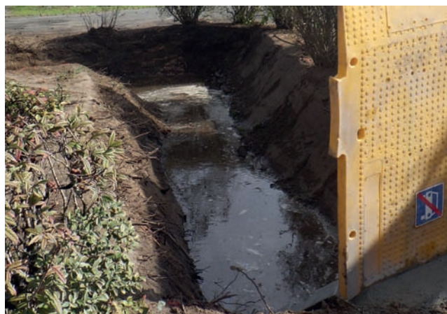
Aménagement des bassins à ciel ouvert destinés à recueillir les eaux de voirie, Le Teich
