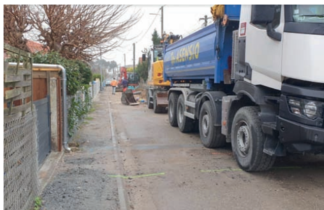
Chargement des déblais à l'avancement des terrassements, Andernos-les-Bains
