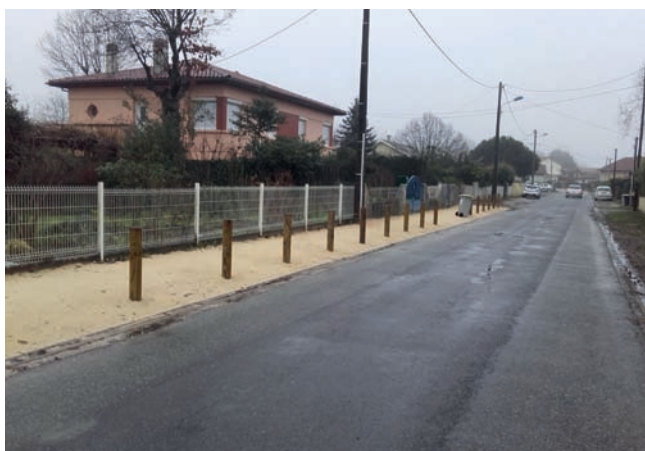
Aménagement des accotements après création d'une tranchée drainante, Audenge
