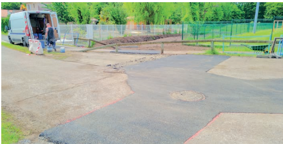
Réfection après repose des traversées d'eaux pluviales et reprise du fossé
