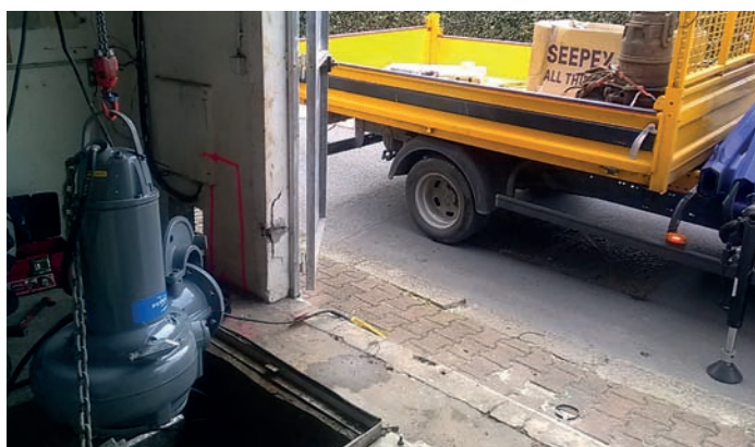
Poste de pompage de Sensevin, Arcachon : renouvellement d'une pompe
