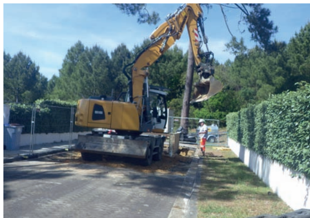
Terrassements pour la pose des SAUL, La Teste de Buch
