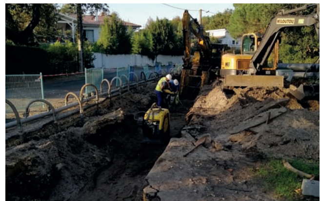
Terrassements pour la pose du collecteur DN 600, Arès
