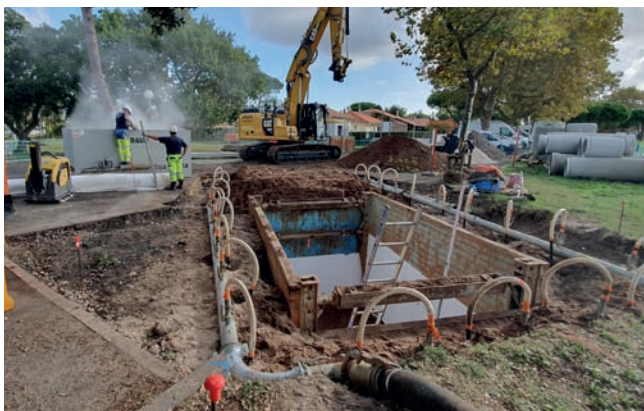
Blindage de la fouille pour la pose du poste de pompage, Arès
