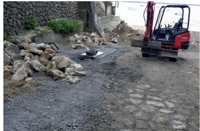
Travaux d'aménagement de l'exutoire après sa pose, La Teste de Buch
