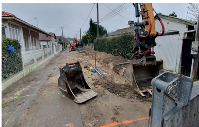
Travaux de terrassements pour la pose du réseau DN 400, Andernos-les-Bains
