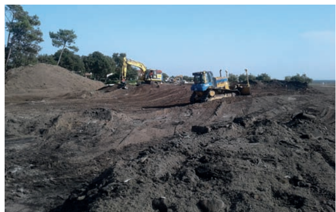
Terrassements en masse pour la création des noues, Lanton
