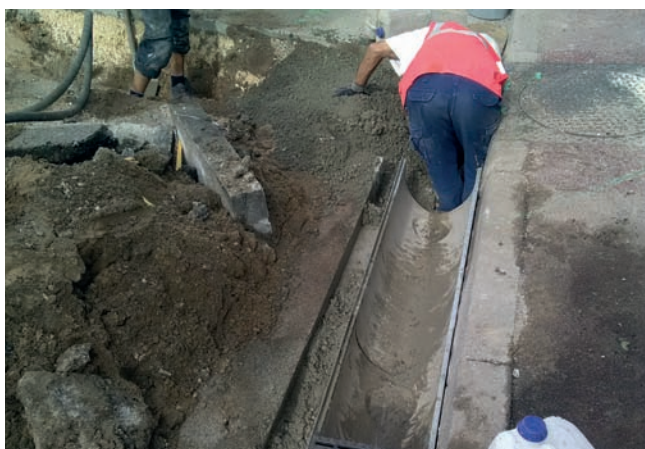
Pose de caniveaux pour augmenter la capacité d'absorption des installations
