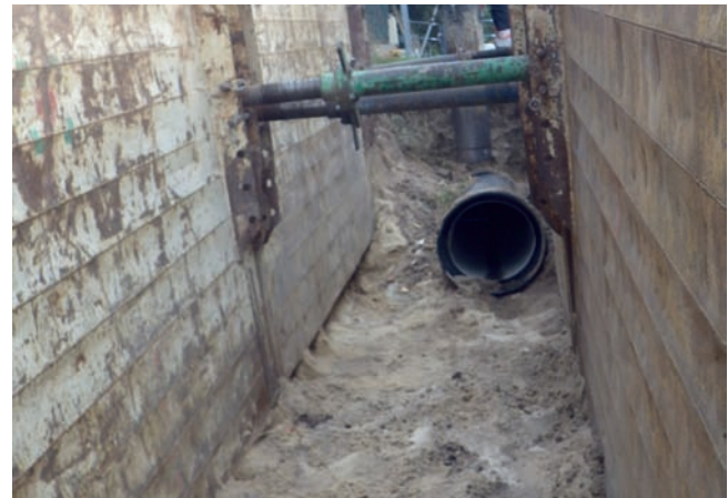
Terrassements à l'aspiratrice pour la suppression de la contre pente existante, La Teste de Buch
