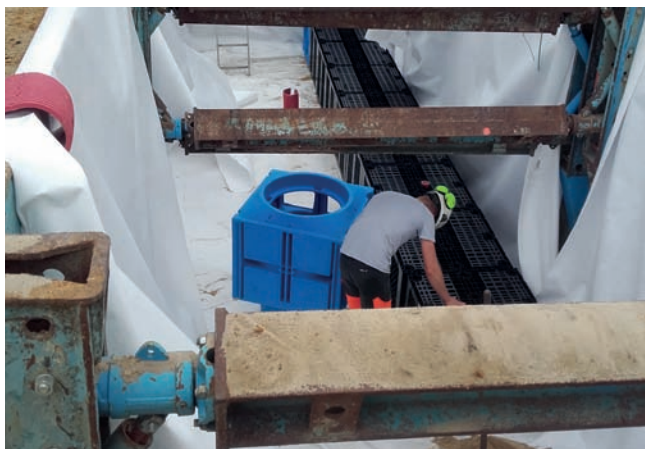
Vue de la fouille blindée et pose des casiers composant la SAUL, La Teste de Buch
