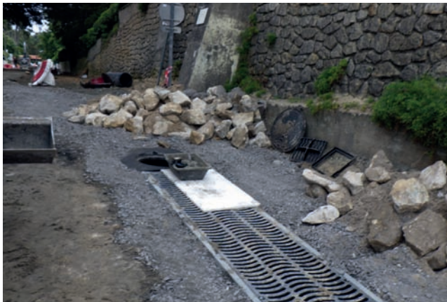
Pose d'un caniveau transversal pour évacuer les eaux pluviales de la rue des Vendangeurs, tout en piégeant les macro-déchets, La Teste de Buch
