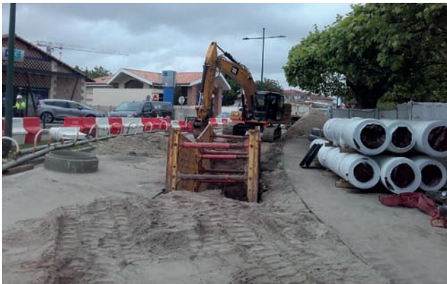
Terrassements et blindage pour la pose du collecteur DN 600, Gujan-Mestras
