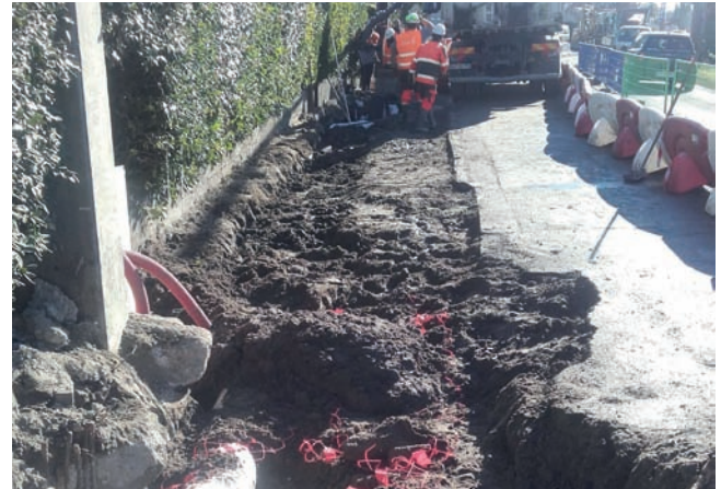
Remblai de la fouille après pose du réseau neuf, Arès
