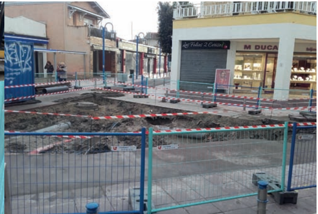
Ouverture de la zone avant la pose d'ouvrage
