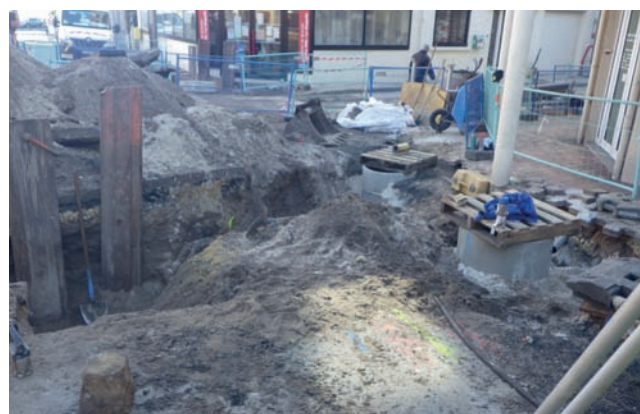
Fouilles blindées pour la pose des bouches d'engouffrement, Arcachon
