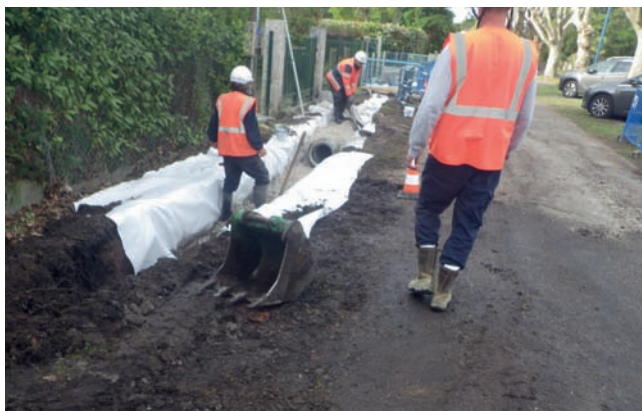
Réalisation d'une tranchée pour la pose du réseau neuf, Andernos-les-Bains
