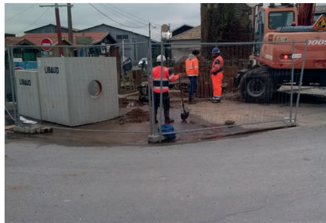
Regards préfabriqués pour le montage du clapet antiretour, Gujan-Mestras
