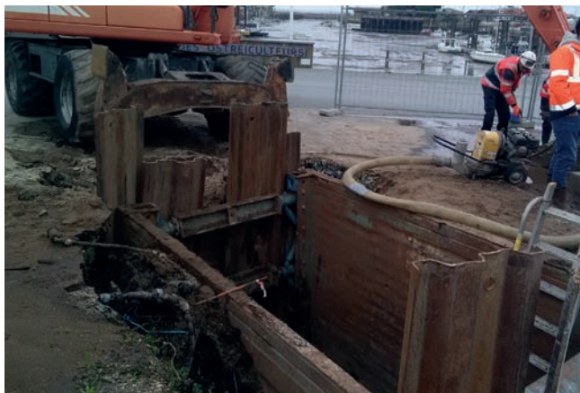
Vue de la fouille blindée pour la pose du regard de visite avec clapet anti-retour, Gujan-Mestras
