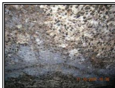
Fissures et dégradation apparentes des bétons
