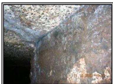
Fissures et dégradation apparentes des bétons
