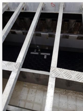
Ci-dessous, exemple de la mise en œuvre du supportage pour maintenir les blocs lamellaires
