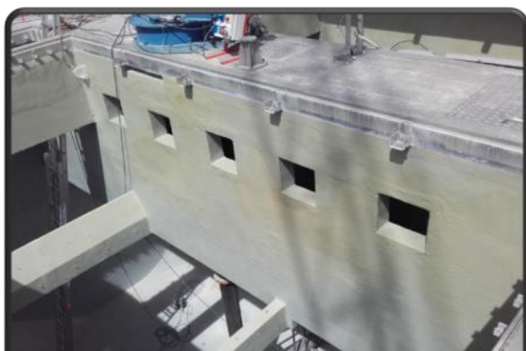
Rénovation du décanteur lamellaire de la tranche 1
