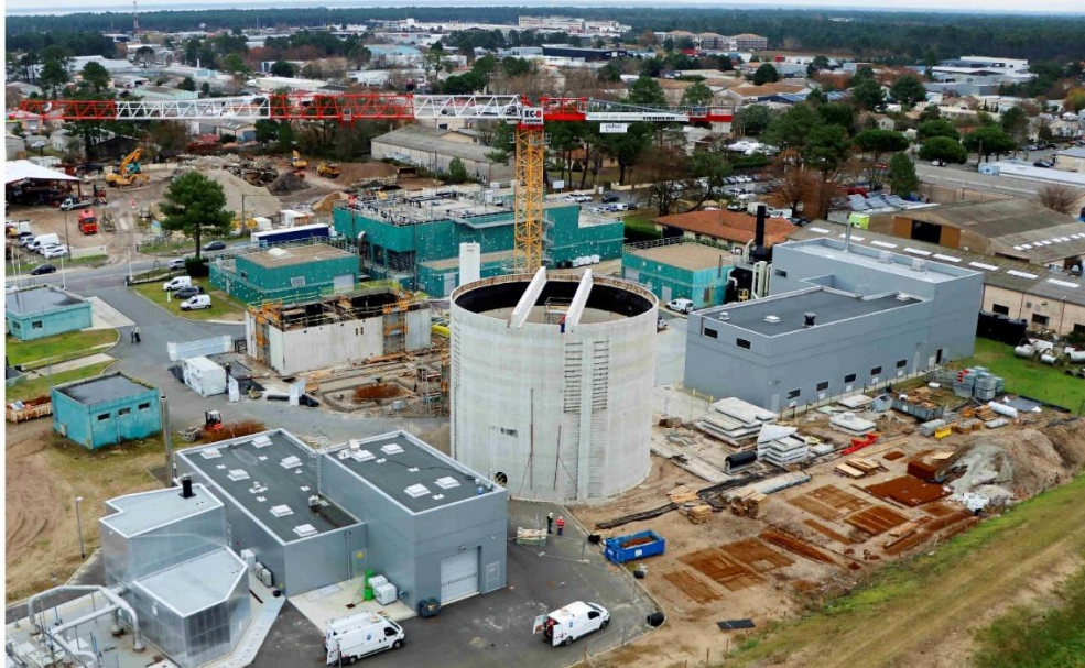
METHA SIBA – Pose poutres plancher haut 35T DIGESTEUR, fin voiles bâches amont aval BATIMENT
