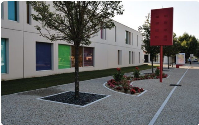
Trottoir en béton désactivé devant la médiathèque, Lanton
