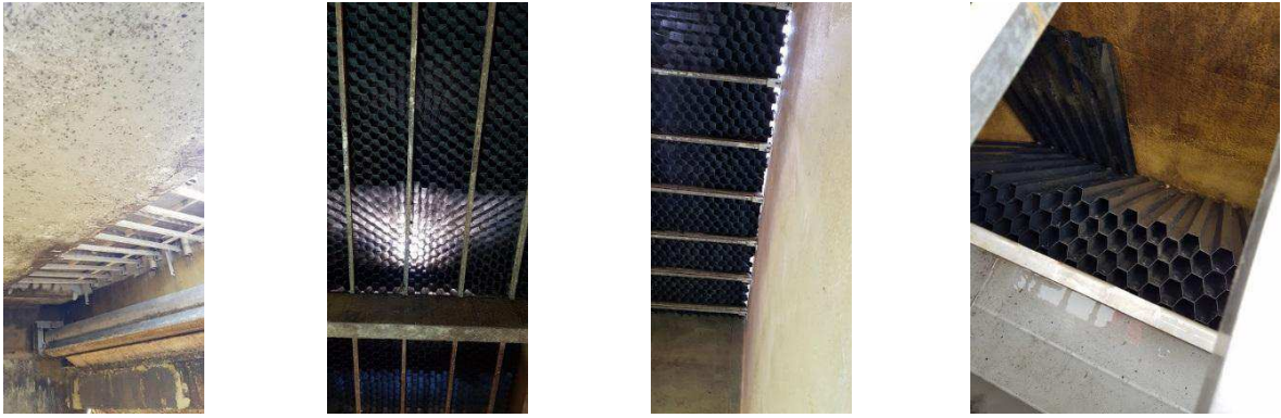
Ci-dessus, photos prises lors de l'inspection commune
