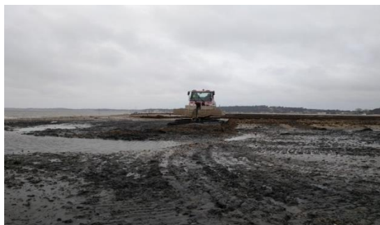
Comblement du trou d'eau par la dameuse
