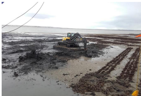
Pelle sur ponton flottant
