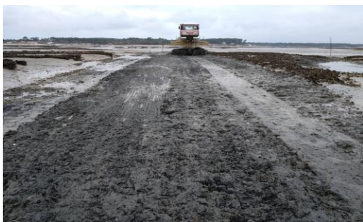
La dameuse nivelle le terrain
