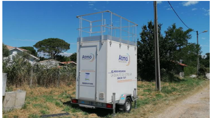
Figure 3 : Installation de l'aethalomètre AE33 dans une remorque sur le site Cassy
