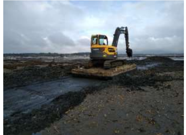
La pelle sur ponton flottant
