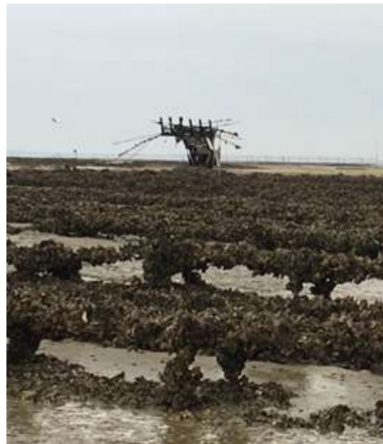
Figure 13 : Bull équipé d'une fourche permettant le retrait des ferrailles
