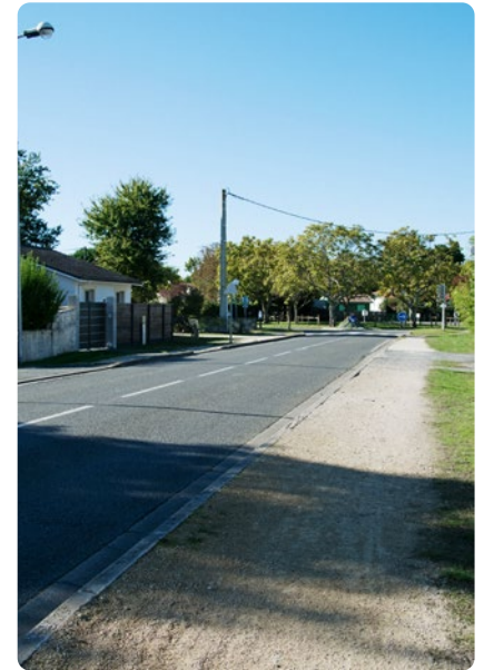
Trottoir en calcaire
