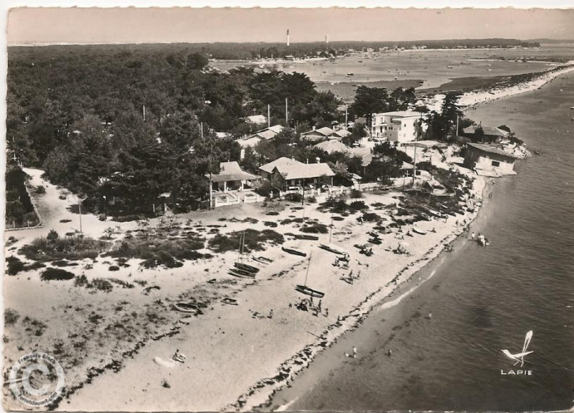
Figure 2-5 : Vue d'avion prise en 1962 avec la plage des Courlis en premier plan puis la pointe Hortense et le Mimbeau à l'arrière-plan. On observe à la pointe Hortense un ancien blockhaus
