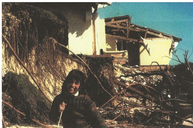
Figure 1-2 : Maison Balguerie en 1985 avant que des travaux d'envergure soient entrepris par M. Bartherotte et qui ont permis de sécuriser l'ensemble de La Pointe.
