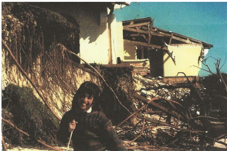
Figure 2-6 : Maison Balguerrie en 1985 avant que des travaux d'envergure soient entrepris par M. Bartherotte et qui ont permis de sécuriser l'ensemble de La Pointe.
