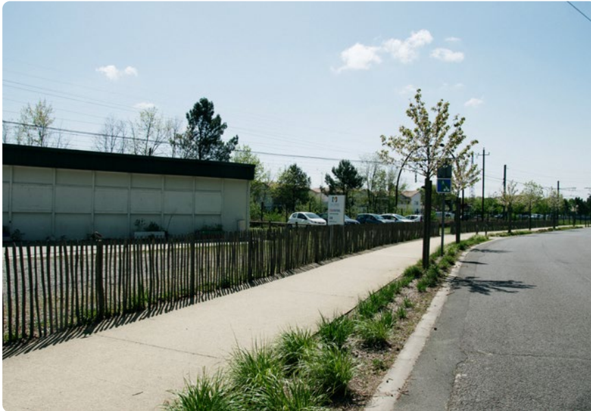
Trottoir en béton désactivé
