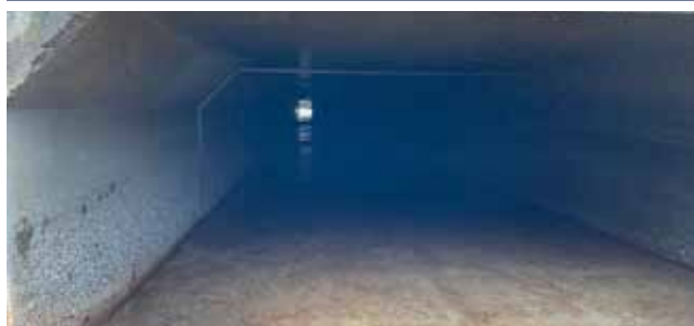
Hydrocurage du pont cadre (Procession) La Teste de Buch
