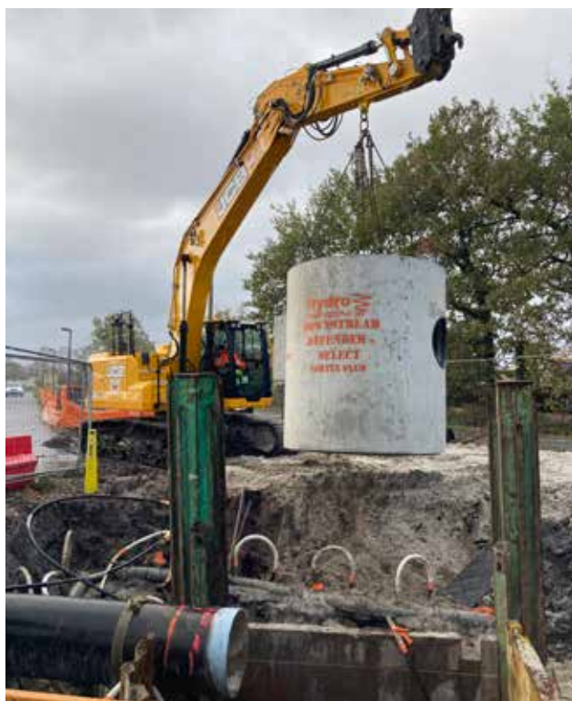
Mise en place de l'ouvrage de pré-traitement
