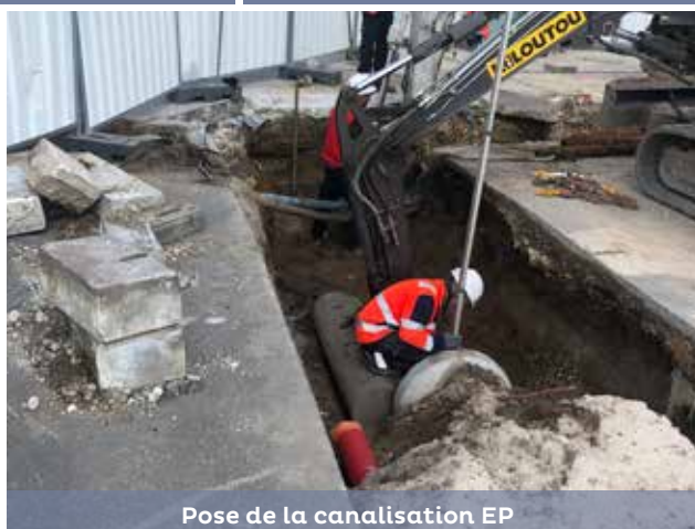
Réalisation de la tranchée pour la pose de la canalisation
