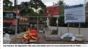
Les travaux de régulation des eaux pluviales sont en cours boulevard de la Teste.
