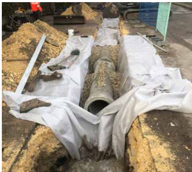
Renouvellement d'une canalisation EP sur 25m Arès- Rue du Port Ostréicole
