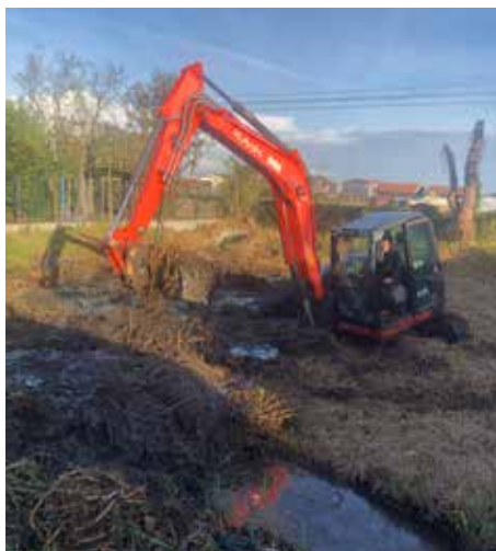
Curage d'un bassin de rétention en cours - Gujan-Mestras
