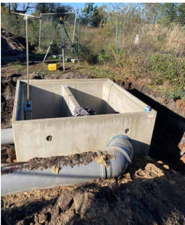
Pose de l'ouvrage de régulation aval
