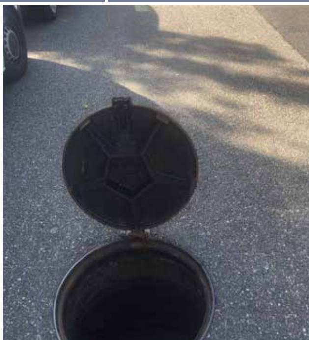
Ouvrage à la côte après réfection de voirie
