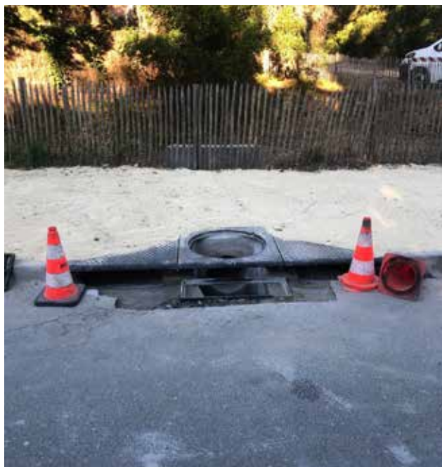
Amélioration de l'engouffrement d'une bouche avaloir
