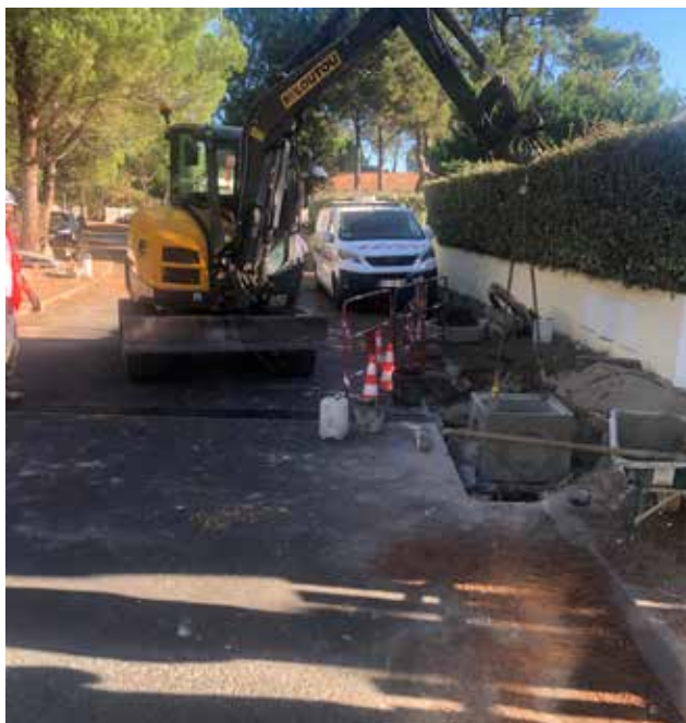
Renouvellement bouche engouffrement avec pose de pré-bouche
