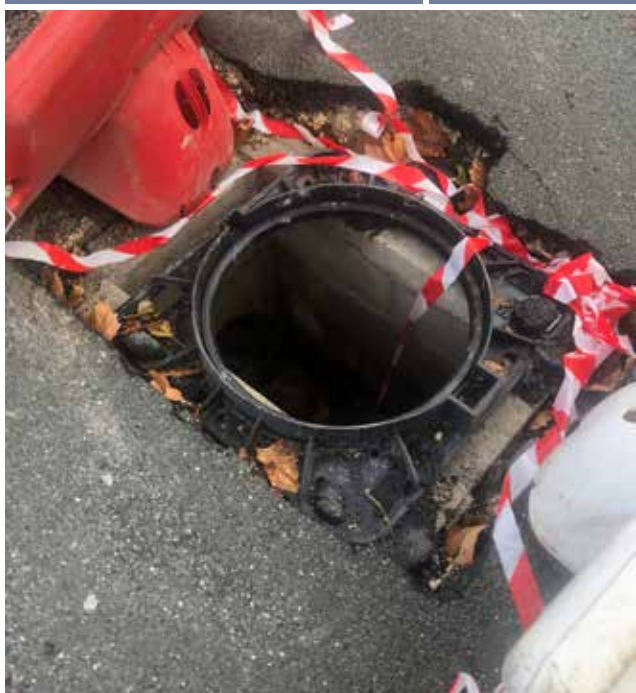
Ouvrage avant mise à la côte
