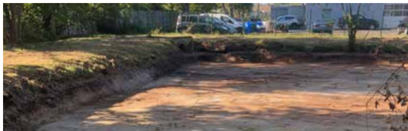
Bassin après curage - Arès
