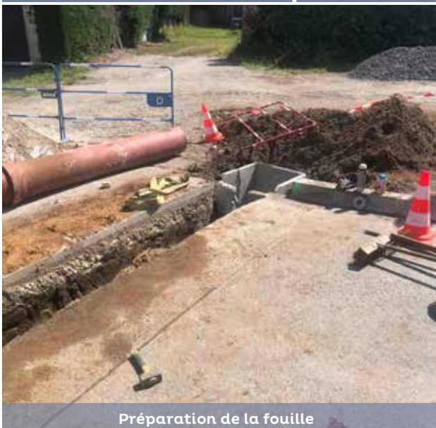
Nivellement du fond de fouille avant pose de la canalisation
