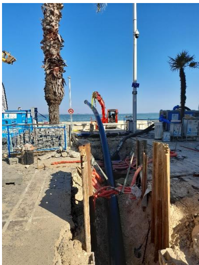
Vue tuyau pendant le tubage
