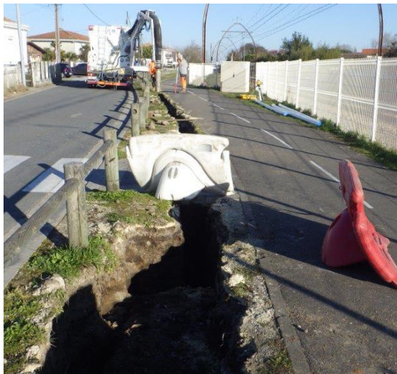
Vue de la tranchée avec aspiratrice
