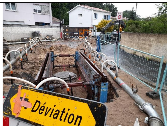
Vue de la tranchée
