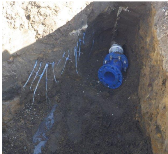
Pose d'un coude en fond de fouille
