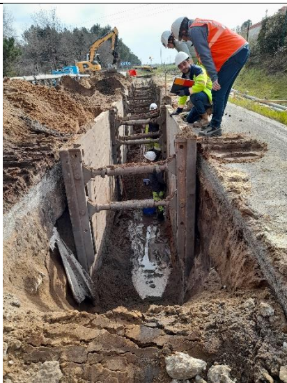
Vue de la tranchée blindée
