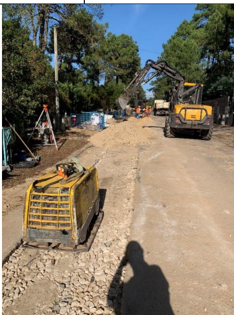
Pose du collecteur et remblaiement de la tranchée
