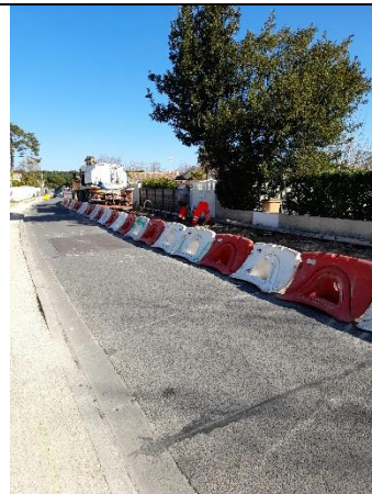
Vue d'ensemble du chantier
