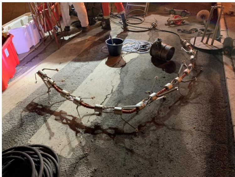
Train de lampes UV permettant de polymériser la gaine
