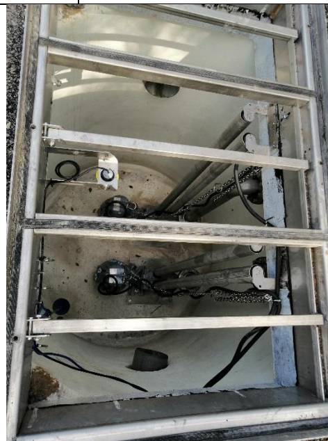
Vue de la bâche – Après pose des équipements
