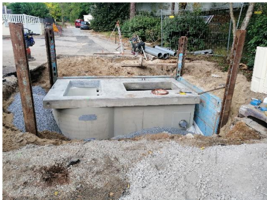
Vue de la tranchée – Pose du poste
