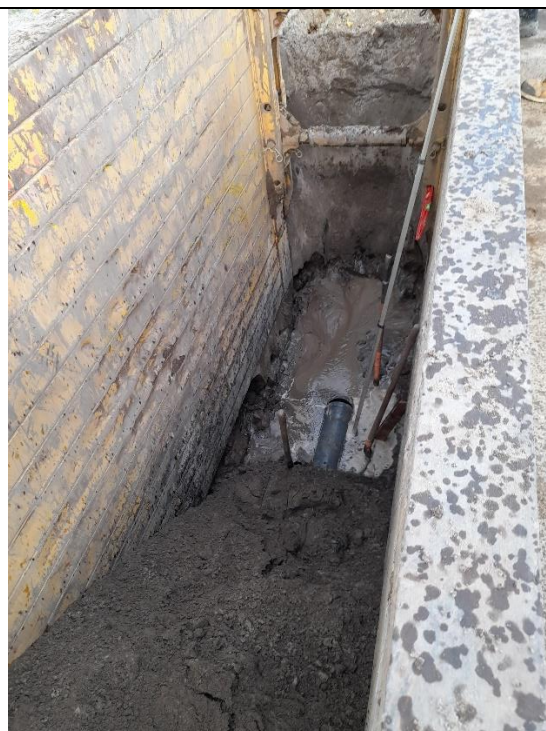
Vue de la tranchée pendant la pose de la conduite principale
