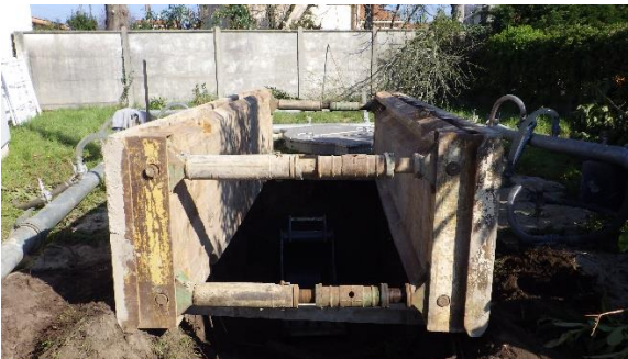
Vue de la préparation de la tranche côté poste
