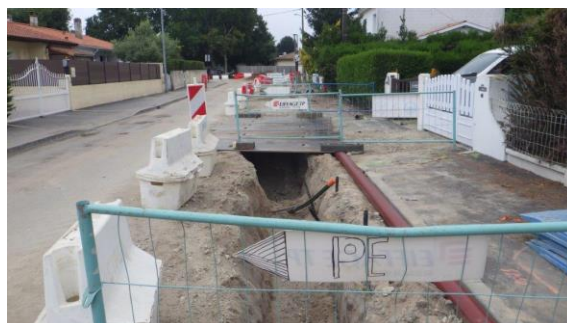
Vue de la tranchée
