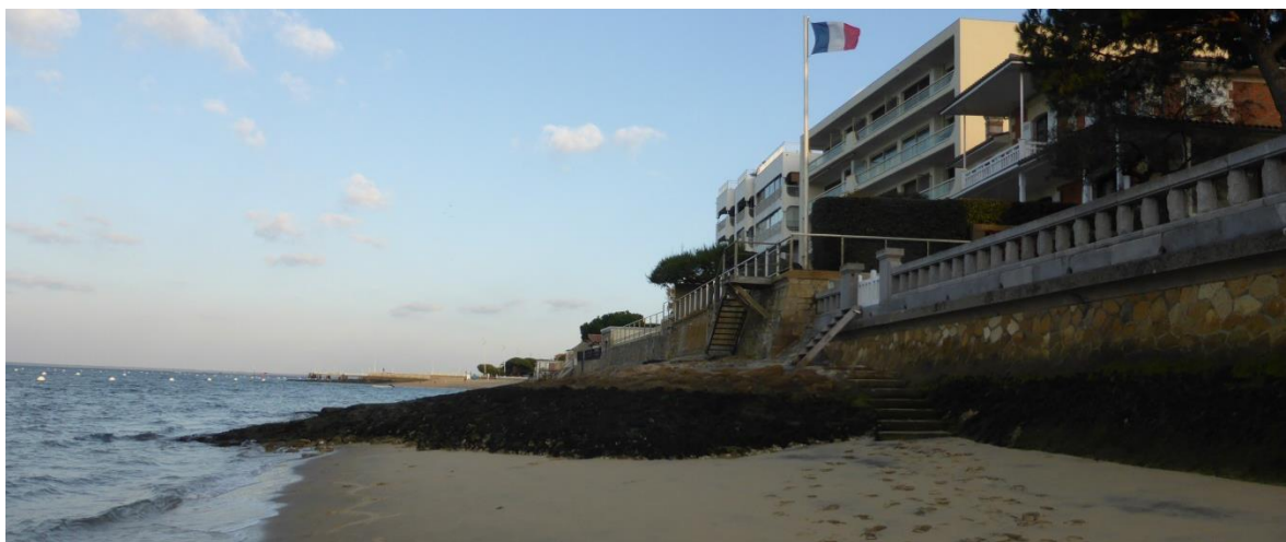
Figure 18. Ouvrage ancien gagnant sur la plage et faisant office d'épi (ARTELIA 2015)
