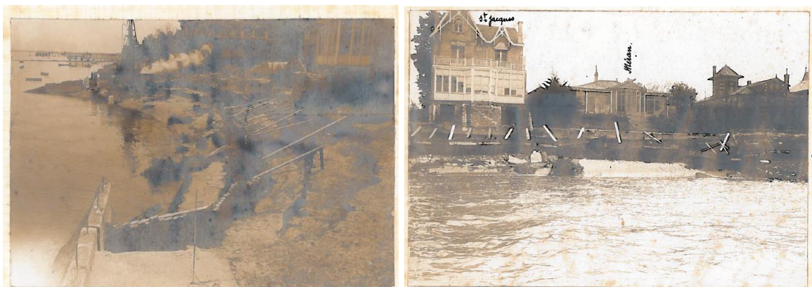
Figure 19. Brèche au niveau de la villa Saint-Yves en 1919 (source : archives DDTM)
