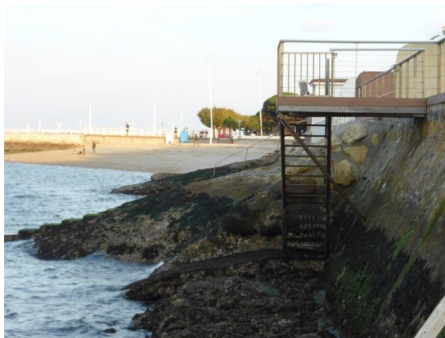
Figure 1. Perrés à proximité de l'épi Legallais (ARTELIA 2015)
