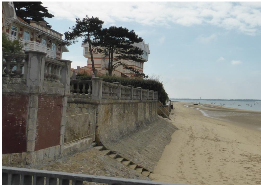
Figure 31 Exemple de perré béton maçonné sur la zone d'étude
