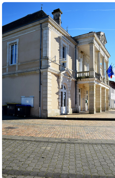
Trottoirs en pavés
