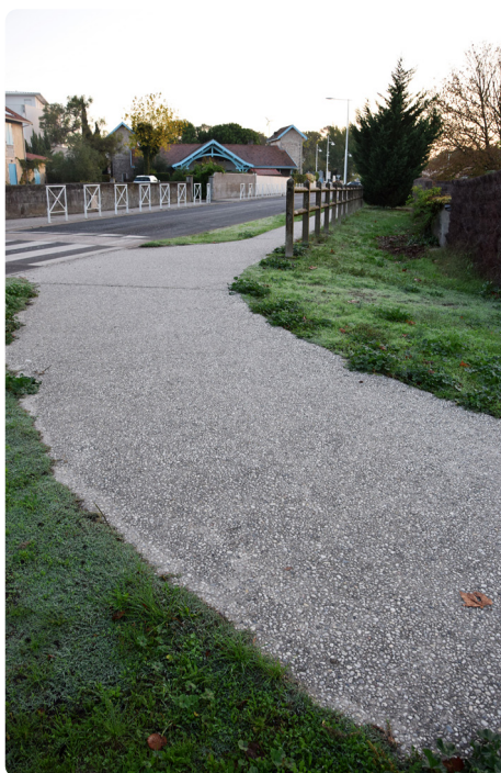
Trottoir en béton désactivé
