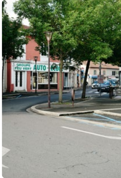
Trottoir en bitume, La Teste de Buch
