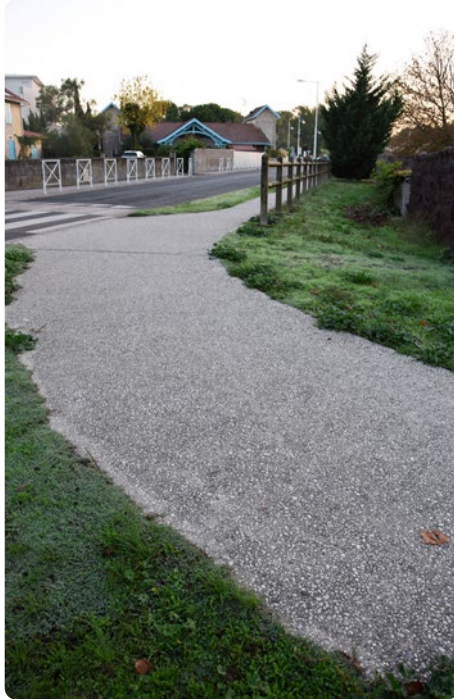
Trottoir en béton désactivé
