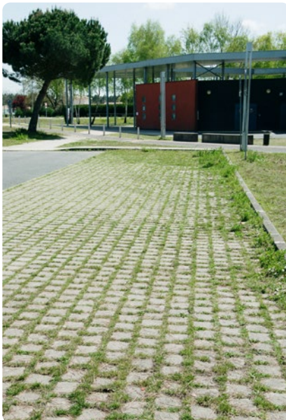
Zone de parking en pavés
