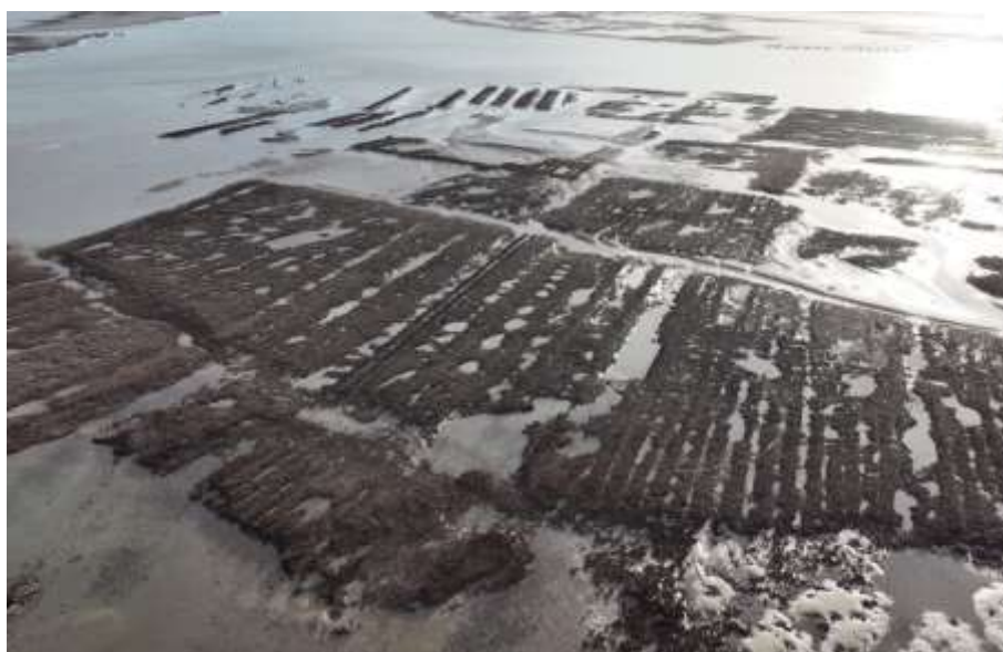
Figure 21 : photographies de la pointe Est du Tès avant travaux
