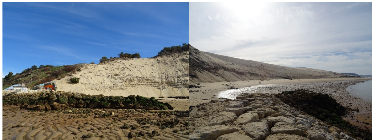
Figure 10. Photographies de l'extrémité de l'ouvrage depuis la plage (gauche) et depuis la crête (gauche)
