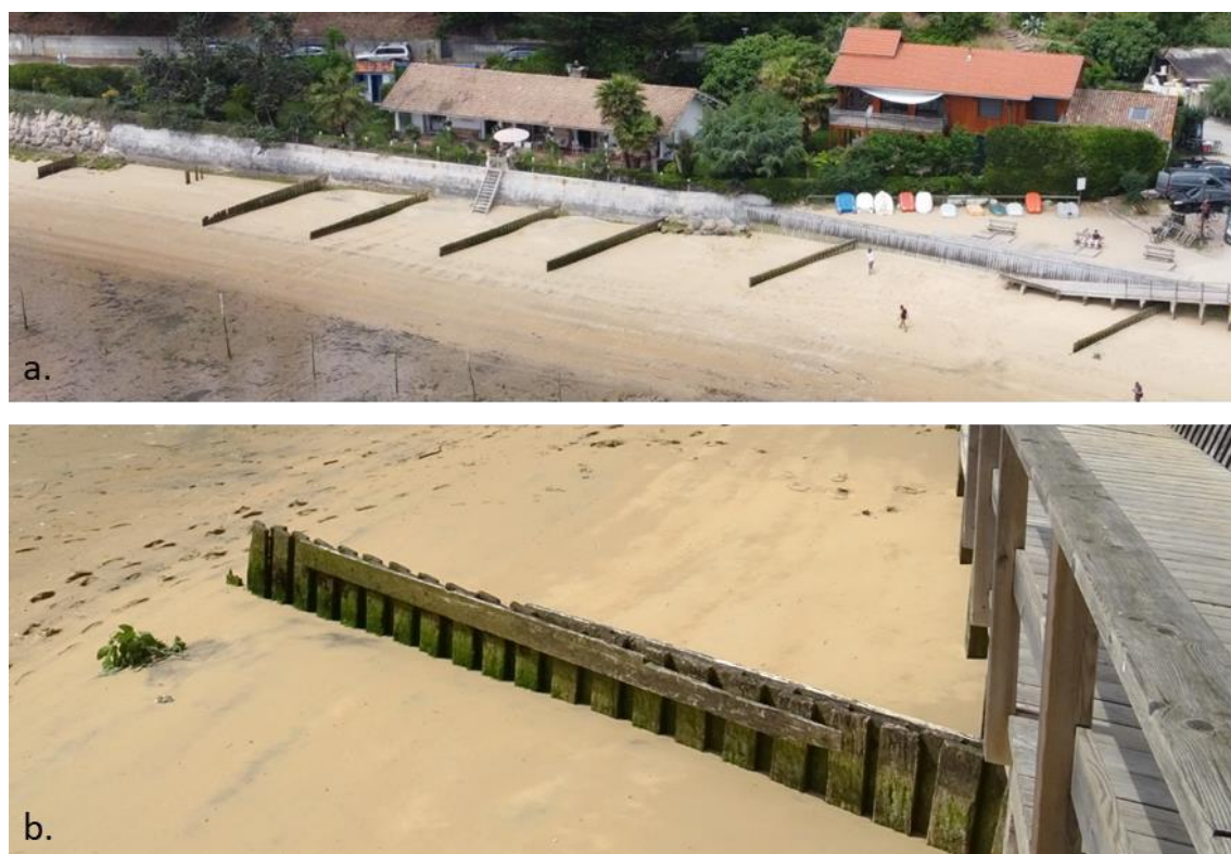
Figure 26. a. Vue drone rapprochée sur les épis, b. Vue rapprochée de l'épi n°12 (CASAGEC, 2021).
