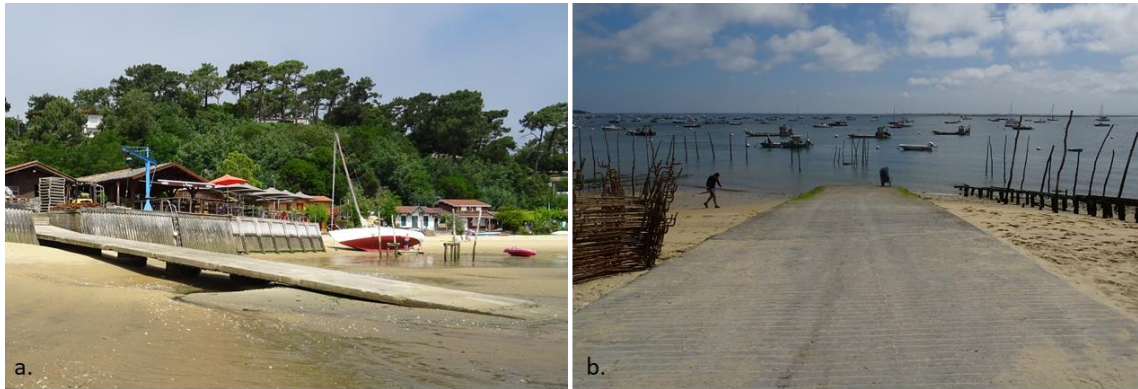
Figure 18. Cales de mise à l'eau, a. cale ostréicole Nord (cale n°1) et b. cale communale (cale n°2).
